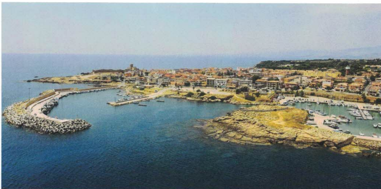
Fig. 4_ Vista delle due darsene, con i moli di sopraflutto e sottoflutto
