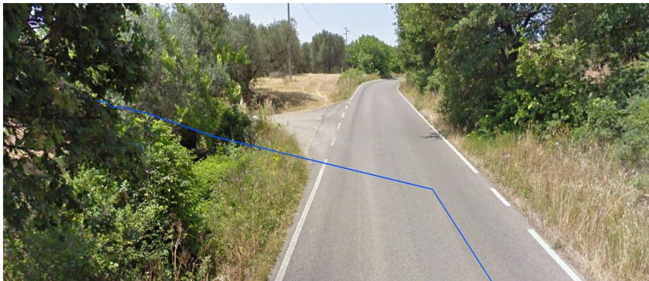
Figura 11 – Innesto da SP 53 a Strada comunale
