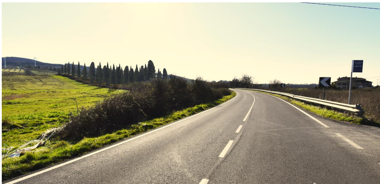
Figura 154 - Veduta lato Nord-Ovest dalla SR Castrense
