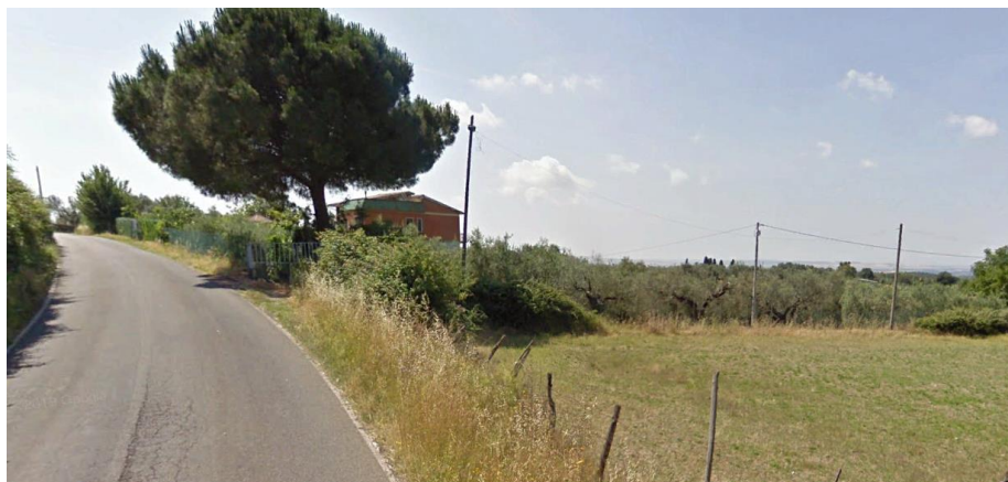
Figura 68 - Punto di innesto tra strada comunale e tratto interpoderaie
