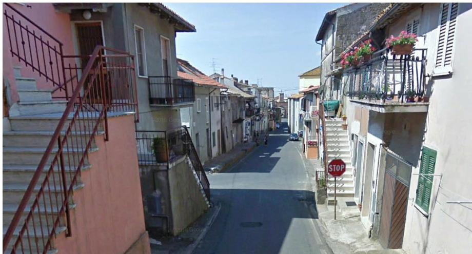
Figura 43 - Incrocio tra SP e strada comunale di scavalco
