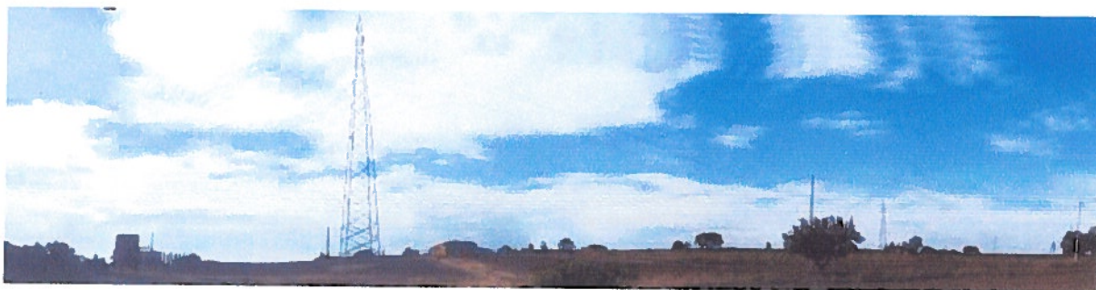
Figura 3: Panoramica linea elettrica esistente presso incrocio SP22-SP6 –Vista verso sud -ANTE OPERAM
