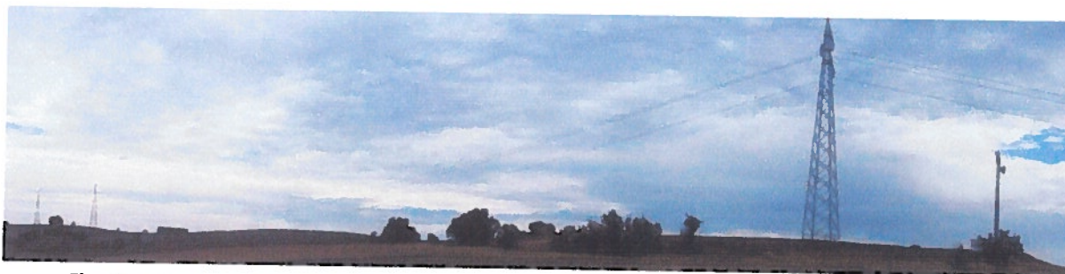
Figura 1: Panoramica linea elettrica esistente presso area SSE di Banzi -Vista verso sud-Est-ANTE OPERAM
