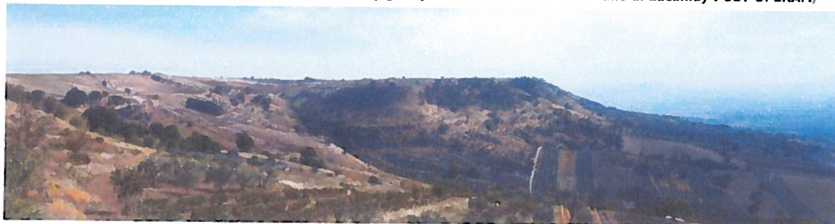
Figura 5: Panoramica linea elettrica esistente presso incrocio SP22-SP6 –Vista verso sud -ANTE OPERAM
