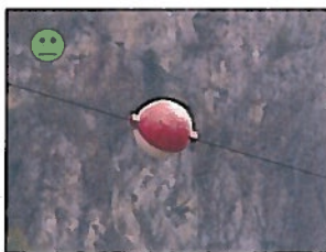
Figura 46: Sfera di poliuretano, su cavo aereo
