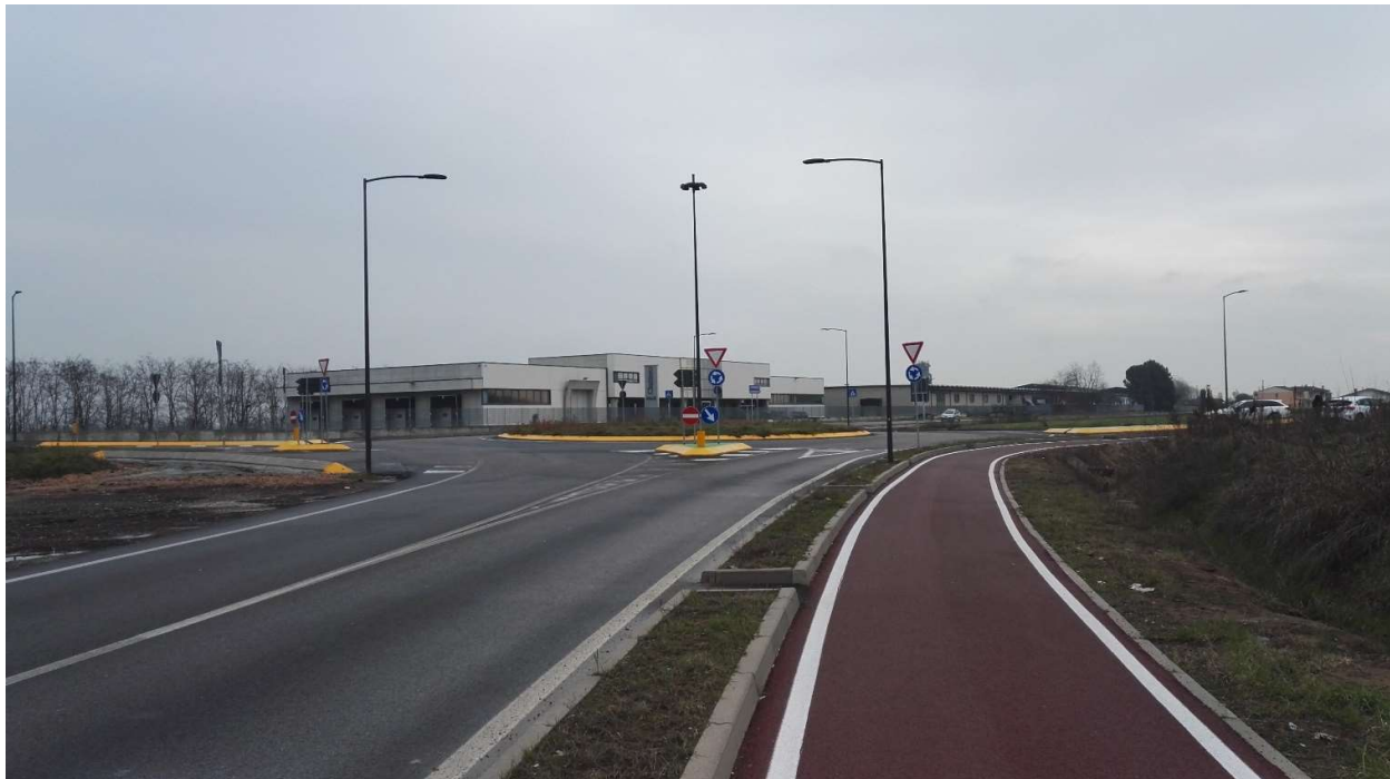
Foto 1 – Rotatoria esistente sulla quale si atterrerà la nuova rampa di svincolo
