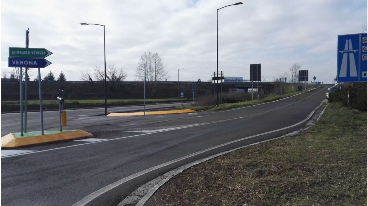
Foto 2 – Rampa esistente di svincolo (da dismettere)
