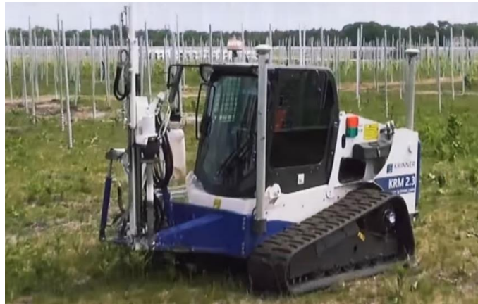
Fig. 5. Esempio di fissaggio delle strutture di supporto
