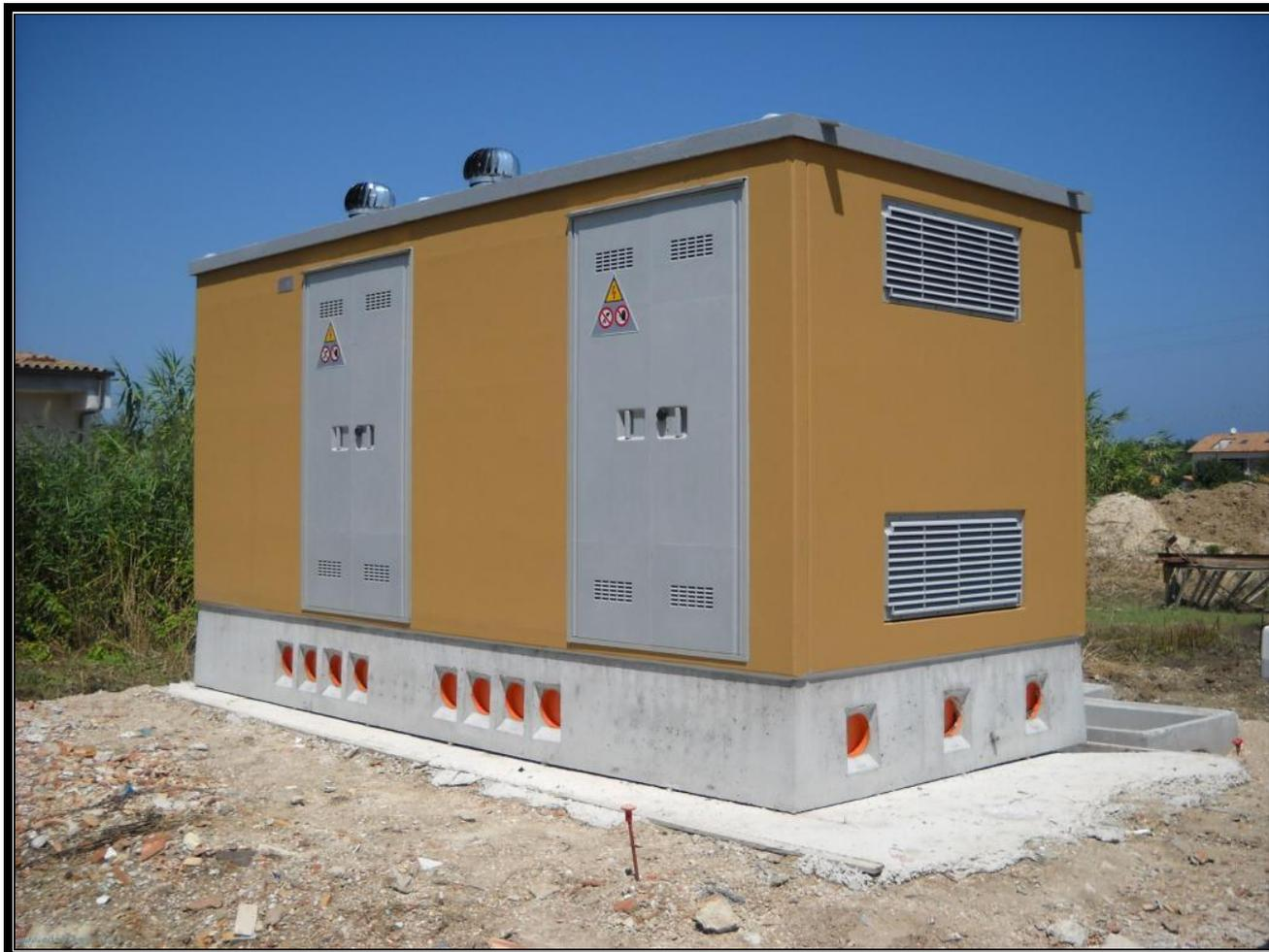
**Figura 8 - Esempio di cabina di parallelo AT**
