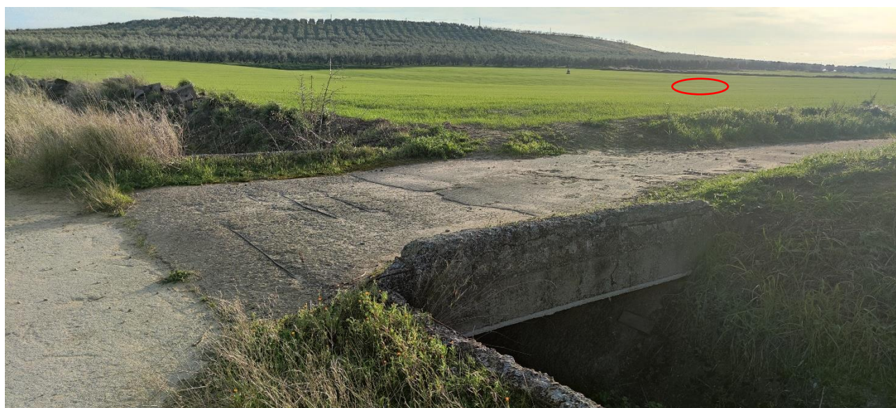
Foto 2: Aree di impianto della C03 cerchiato in rosso in seminativi non irrigui
