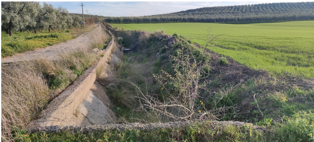
Foto 10: Canale a monte della C03
