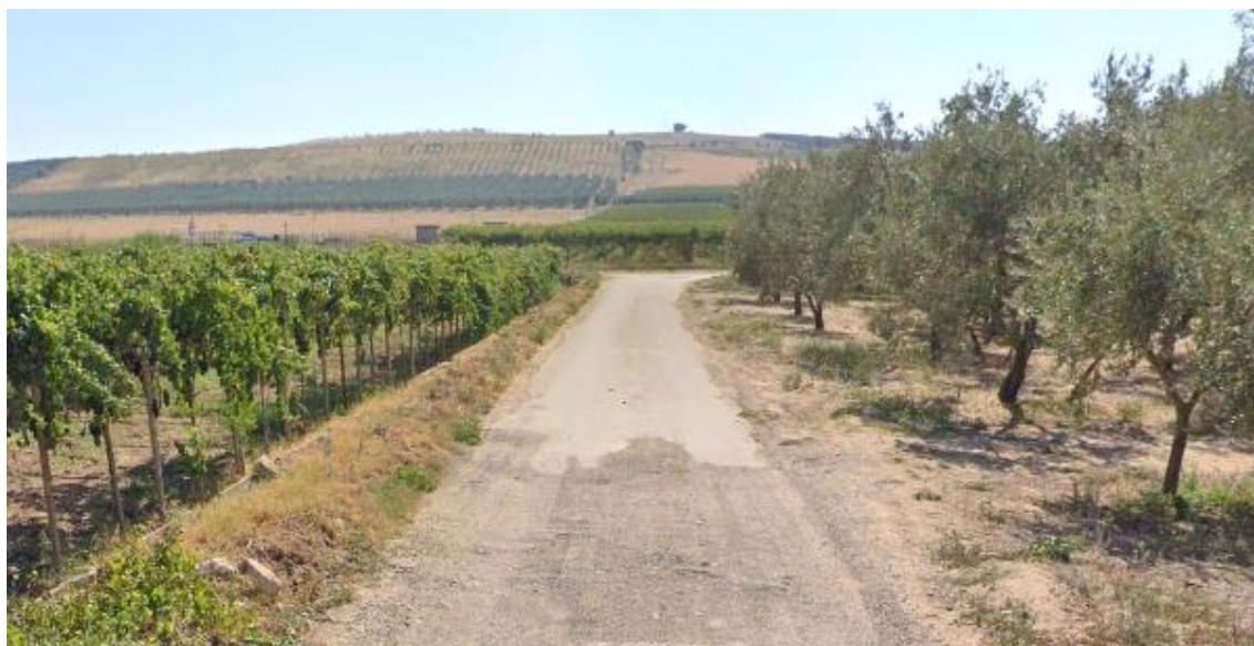
Foto 7: Viabilità delle aree di impianto
