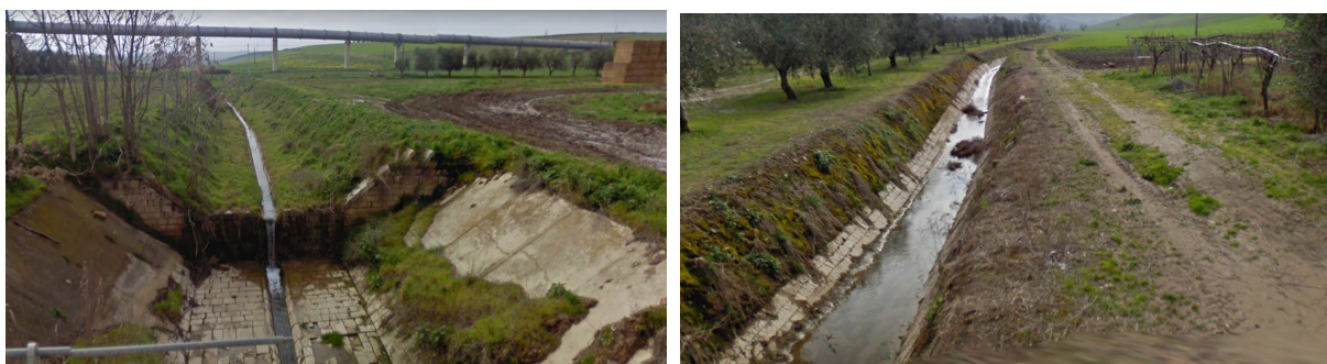
Torrente Lamalunga in prossimità dell'aerogeneratore C01
