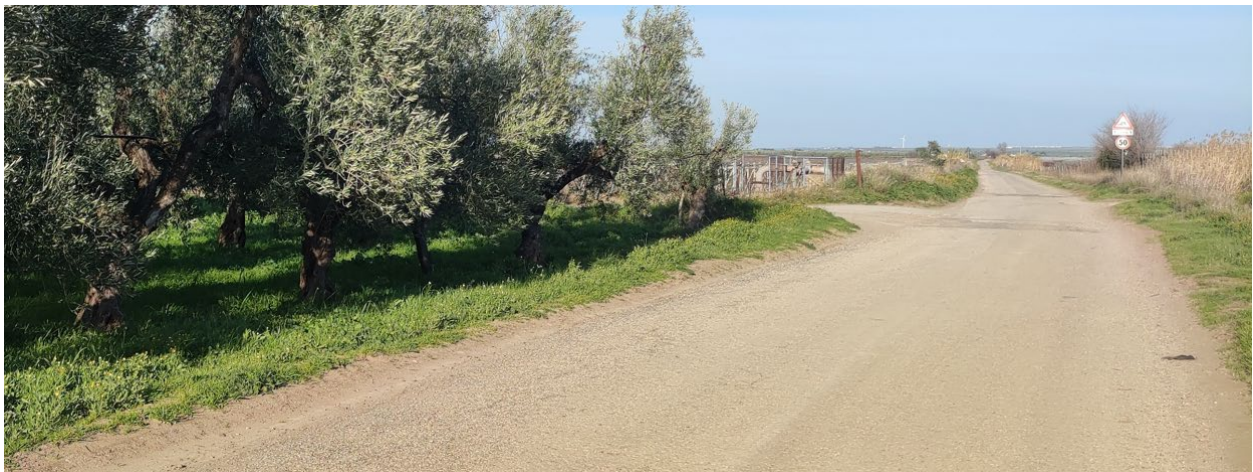
Viabilità in conglomerato bituminoso esistente
