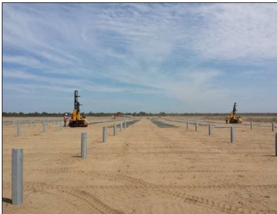
Fig. 7: esempio di posizionamento delle strutture di tipo fisso
