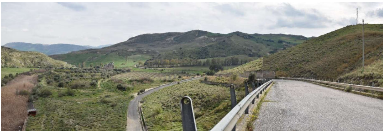
Figura 123 - Stato di fatto del punto di scatto F40
