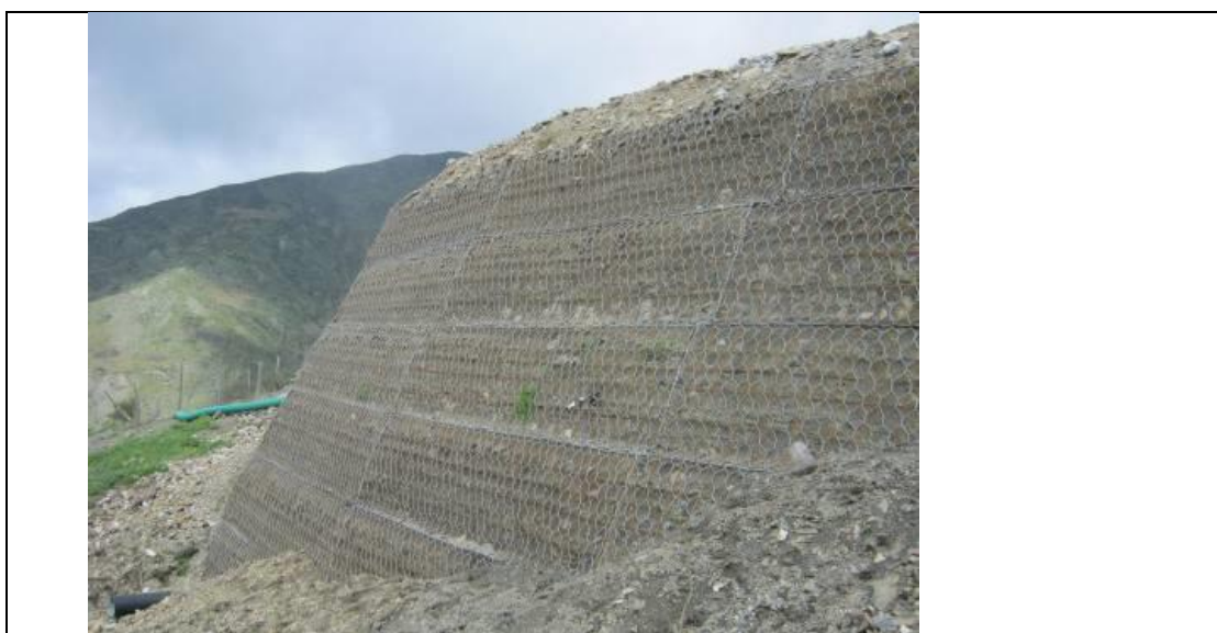
Foto 1 Esempio di opera in terre rinforzate - Fonte HE
