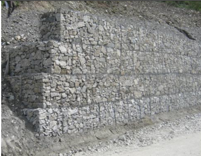
Foto 2 Esempio di opera in gabbioni - Fonte HE
