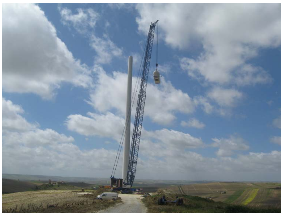
Figura. 74 – Sollevamento della navicella dell'aerogeneratore V90
