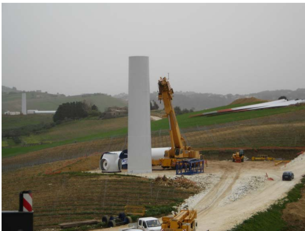
Figura. 71 – Prima fase di montaggio del sostegno tronco-conico dell'aerogeneratore V90
