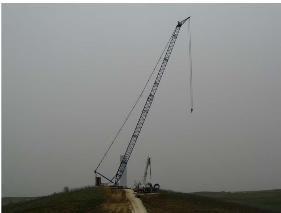
Figura. 72 – Seconda fase di montaggio con la main crane assemblata (aerogeneratore V90)
