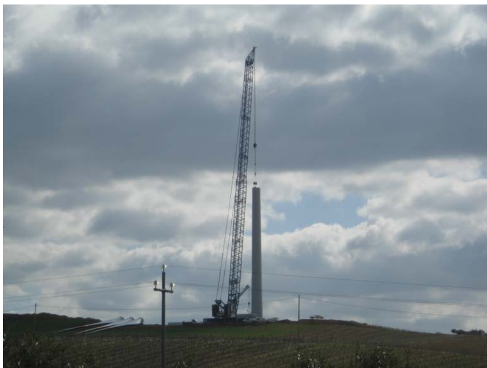
Figura. 73 – Sollevamento delle porzioni del sostegno tronco-conico in acciaio dell'aerogeneratore V90
