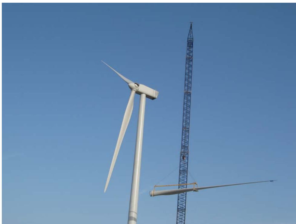
Figura. 75 – Sollevamento della pala del rotore dell'aerogeneratore V90
