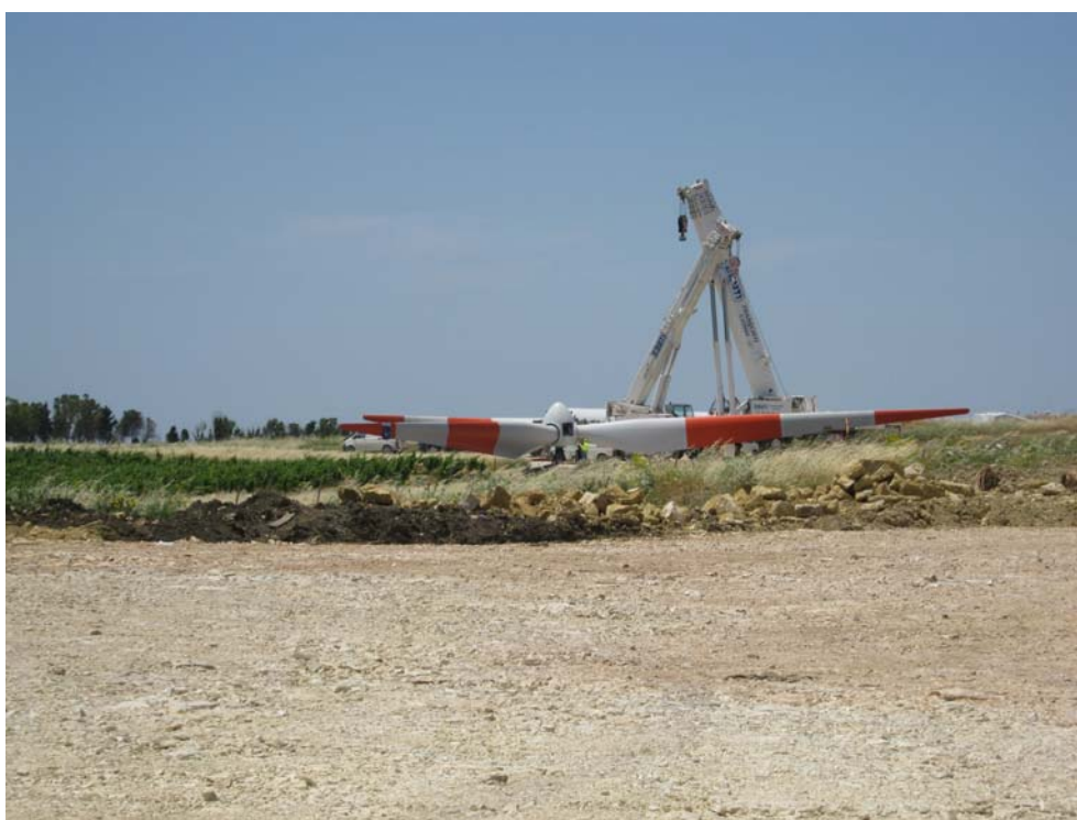
Figura. 76 – Rotore dell'aerogeneratore V52 assemblato a terra prima del sollevamento
