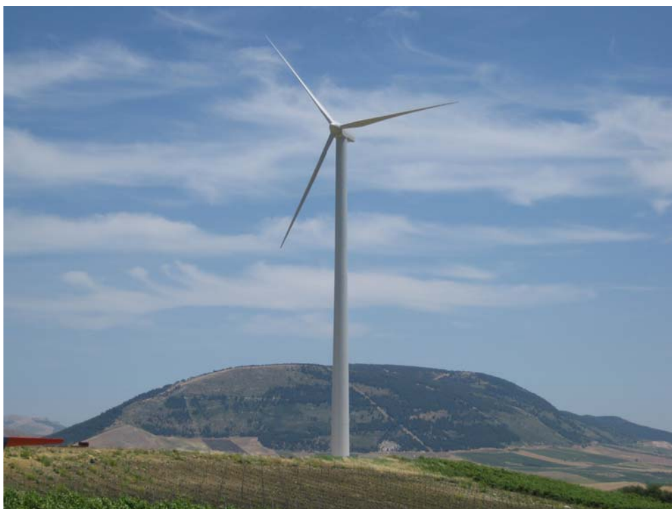
Figura. 77 – Aerogeneratore V52 assemblato
