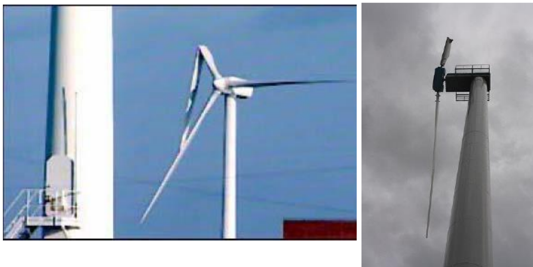
Esempio di rottura di pala senza distacco e con distacco
