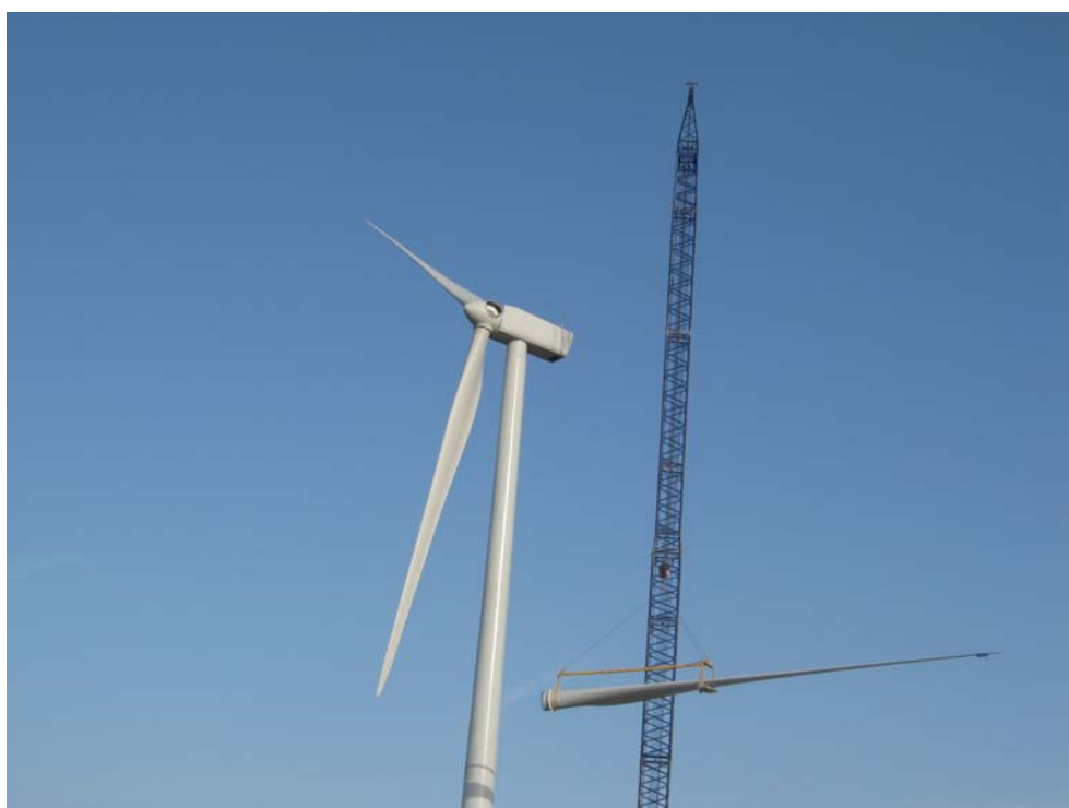
Figura. 21 – Sollevamento della pala del rotore dell'aerogeneratore V90
