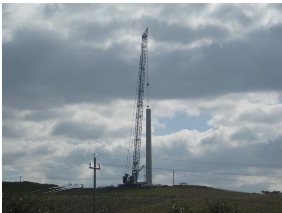
Figura. 19 – Sollevamento delle porzioni del sostegno tronco-conico in acciaio dell'aerogeneratore V90
