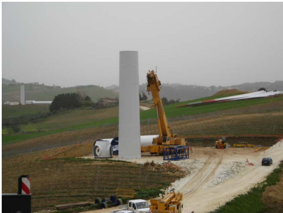
Figura. 17 – Prima fase di montaggio del sostegno tronco-conico dell'aerogeneratore V90
