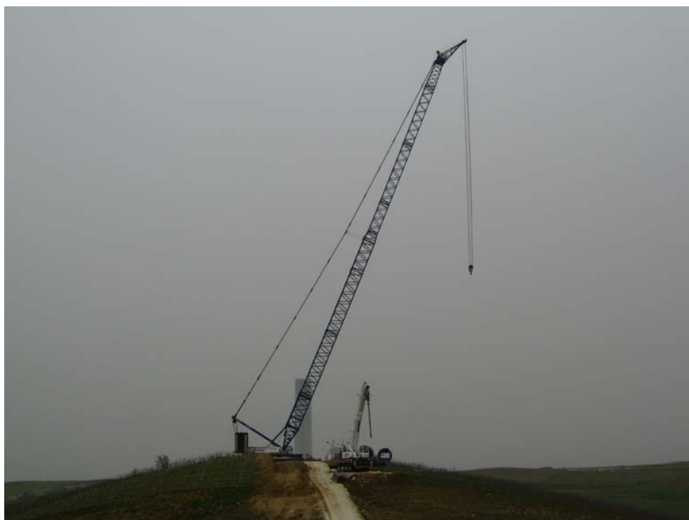
Figura. 18 – Seconda fase di montaggio con la main crane assemblata (aerogeneratore V90)
