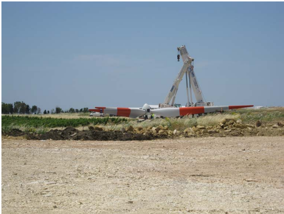
Figura. 22 – Rotore dell'aerogeneratore V52 assemblato a terra prima del sollevamento
