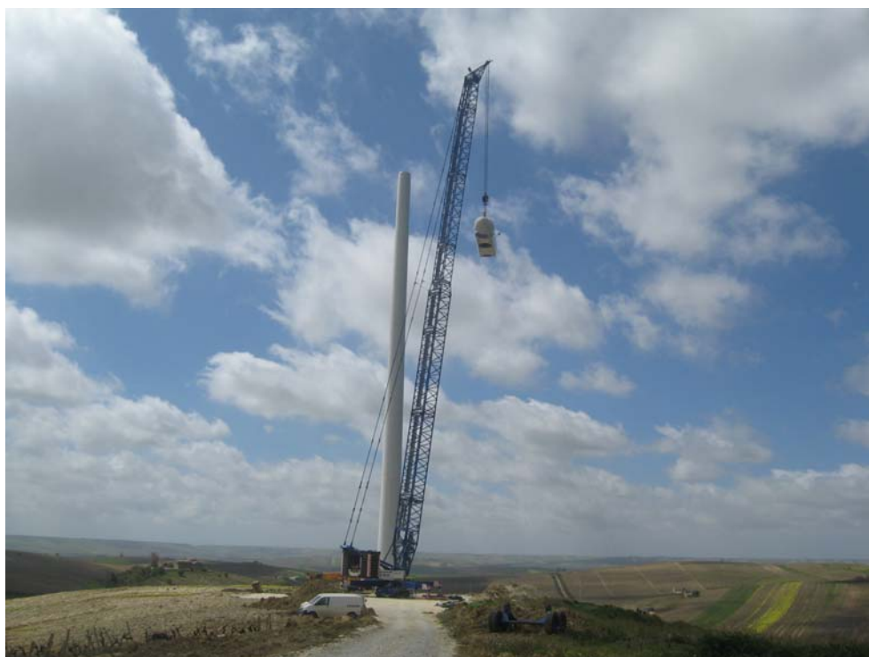
Figura. 20 – Sollevamento della navicella dell'aerogeneratore V90
