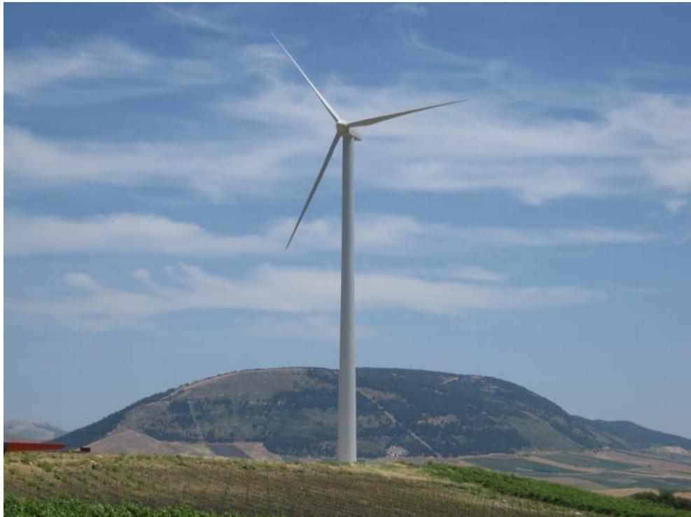
Figura. 23 – Aerogeneratore V52 assemblato
