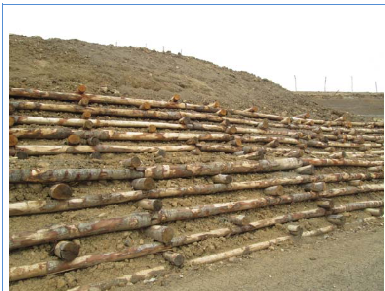
Figura 46 – Esempio di opera in palificate in legname - Fonte HE
