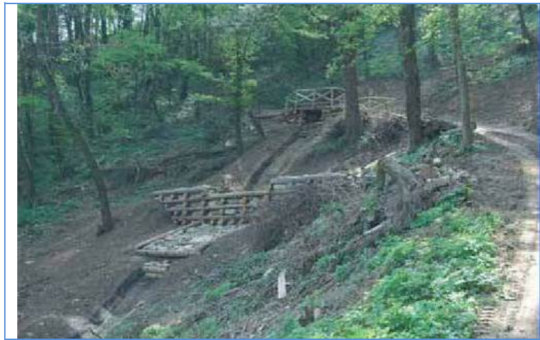
Figura 51 – Esempio di briglie in legname e pietrame - Fonte HE
