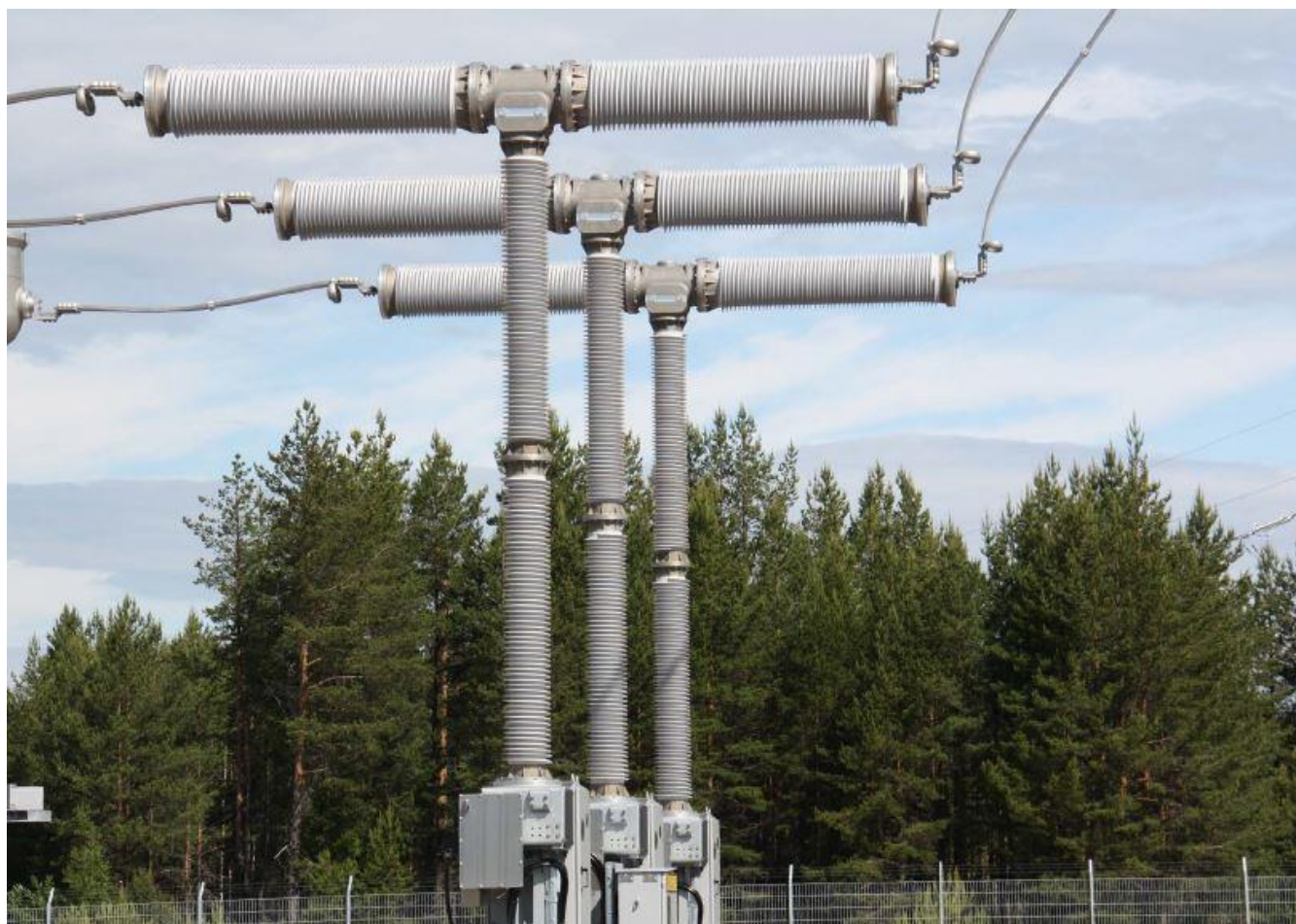
Figura 29 - interruttore 420kV (fonte Siemens)
