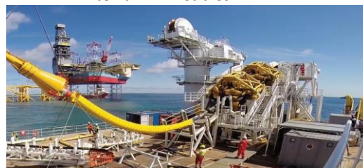
Figura 22 - Particolare dell'imbarcazione posa cavi - NKT Cables
