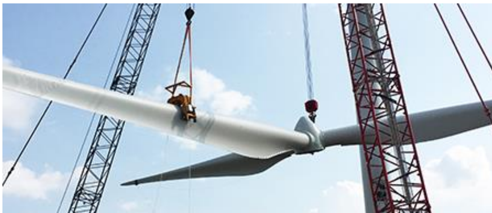
Figura 2.29 - Sollevamento del rotore (Fonte: Elronic Wind solution)
