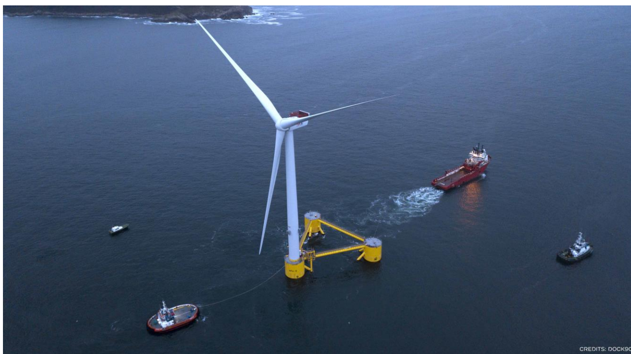
Figura 2.30 - Esempio dell'operazione di rimorchio (Fonte Windfloat Atlantic Project)
