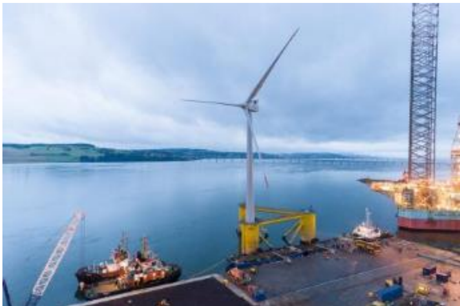
Figura 2.26 - Assemblaggio piattaforma galleggiante (Fonte kinkardine -Cobra)
