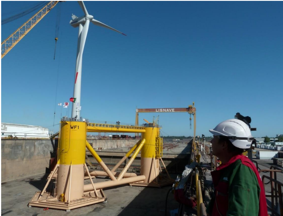
Figura 2.27 - Fasi di assemblaggio della piattaforma galleggiante (Fonte Windfloat Atlantic Project)
