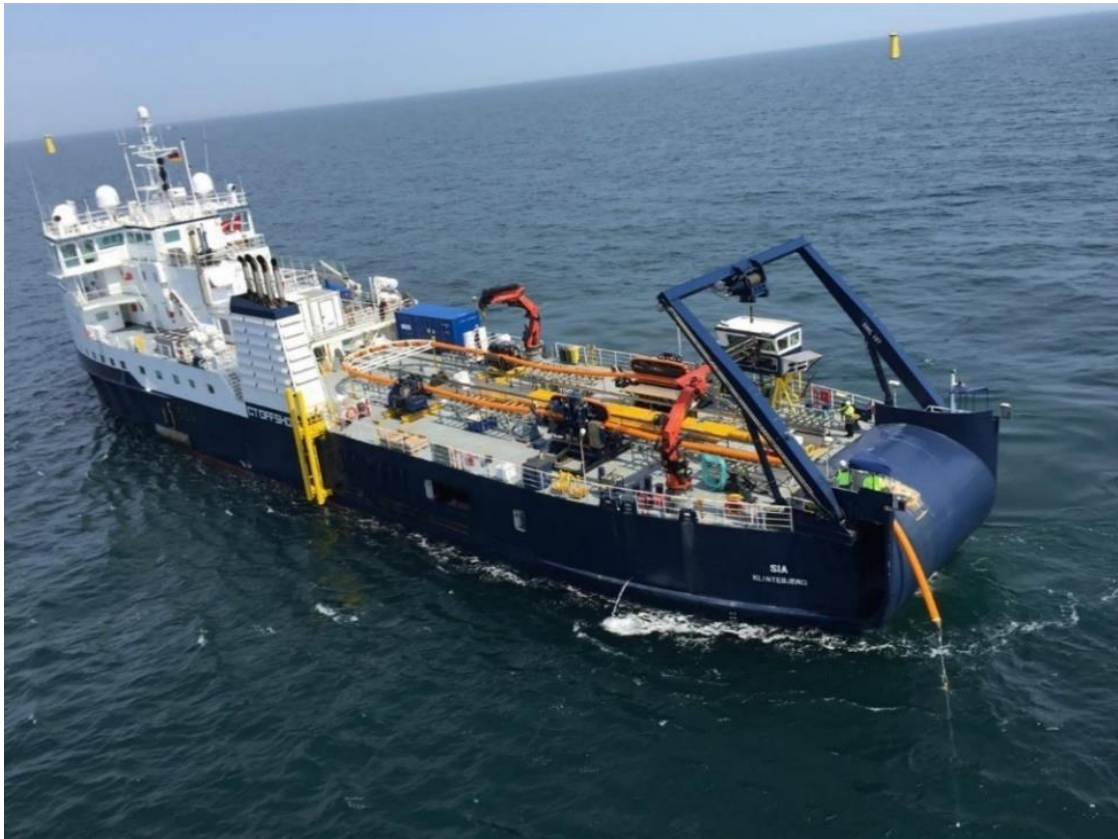
Figura 2.31 - Illustrazione dell'installazione del cavo (Fonte: Offshore Gode-wind)
