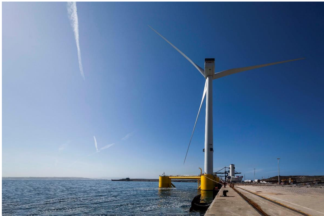
Figura 2.28 - Fasi di assemblaggio della piattaforma galleggiante (Fonte Windfloat Atlantic Project)
