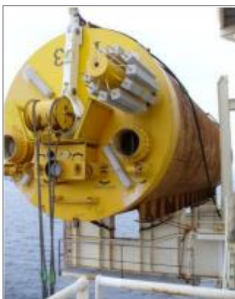
Figura 2.9 - Illustrazione di palo infisso per aspirazione
