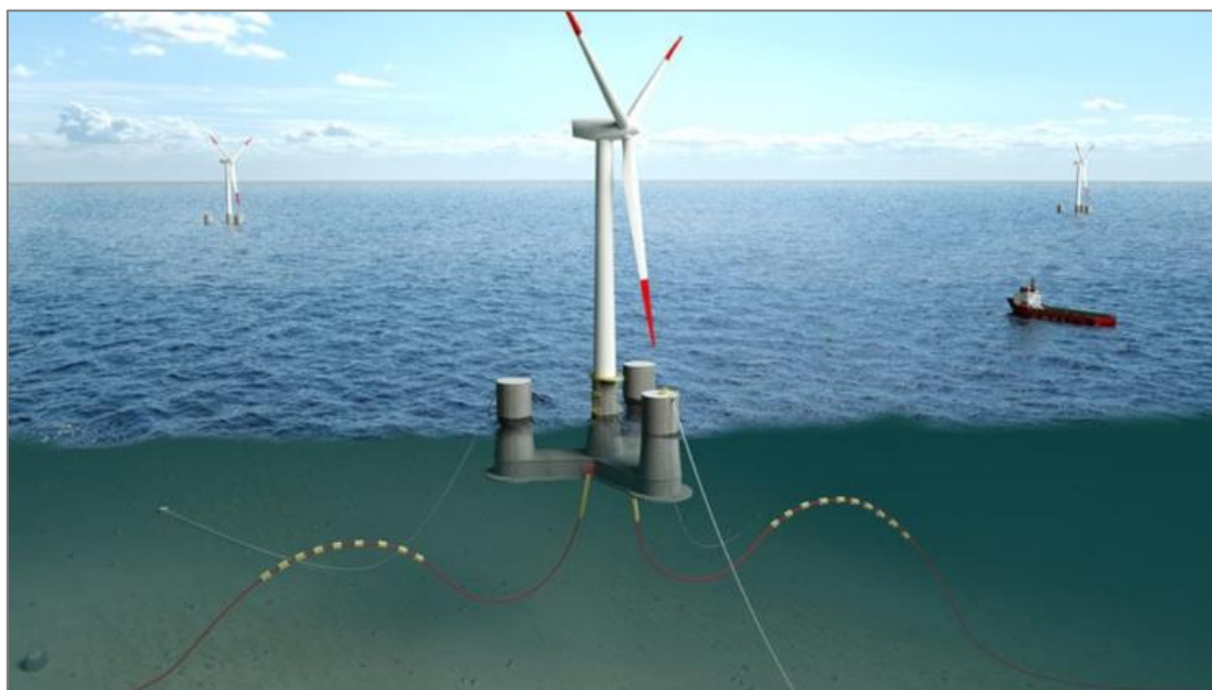
Figura 2.3 - Esempio struttura di galleggiamento della turbina (Fonte: Science Direct https://www.sciencedirect.com/science/article/pii/S0142061521003677 )
