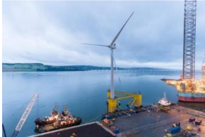
Figura 6-2 – Assemblaggio piattaforma galleggiante (Fonte kinkardine -Cobra)
