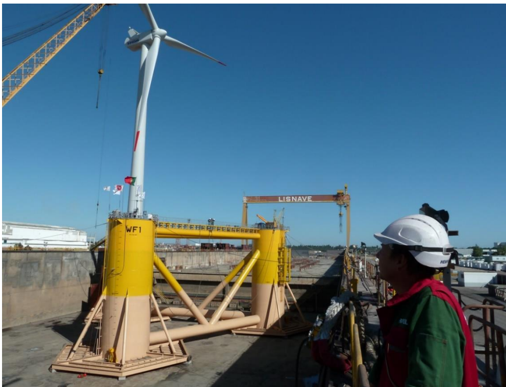
Figura 6-3 – Fasi di assemblaggio della piattaforma galleggiante (Fonte Windfloat Atlantic Project)
