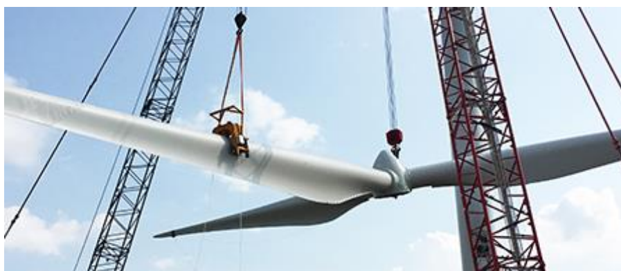
Figura 6-5 – Sollevamento del rotore (Fonte: Elronic Wind solution)
