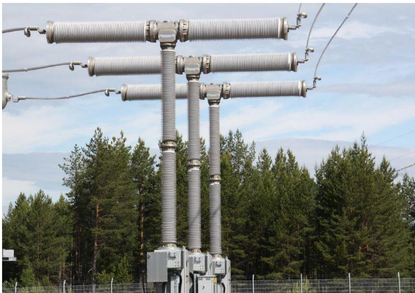
Figura 30 - interruttore 420kV (fonte Siemens)
