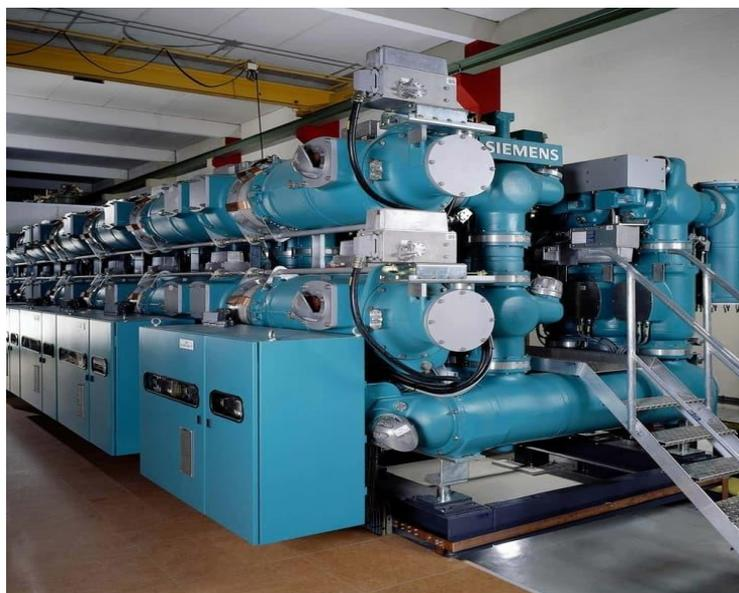
Figura 17 - Celle AT 380kV in stazione Off-shore (fonte Siemens)
