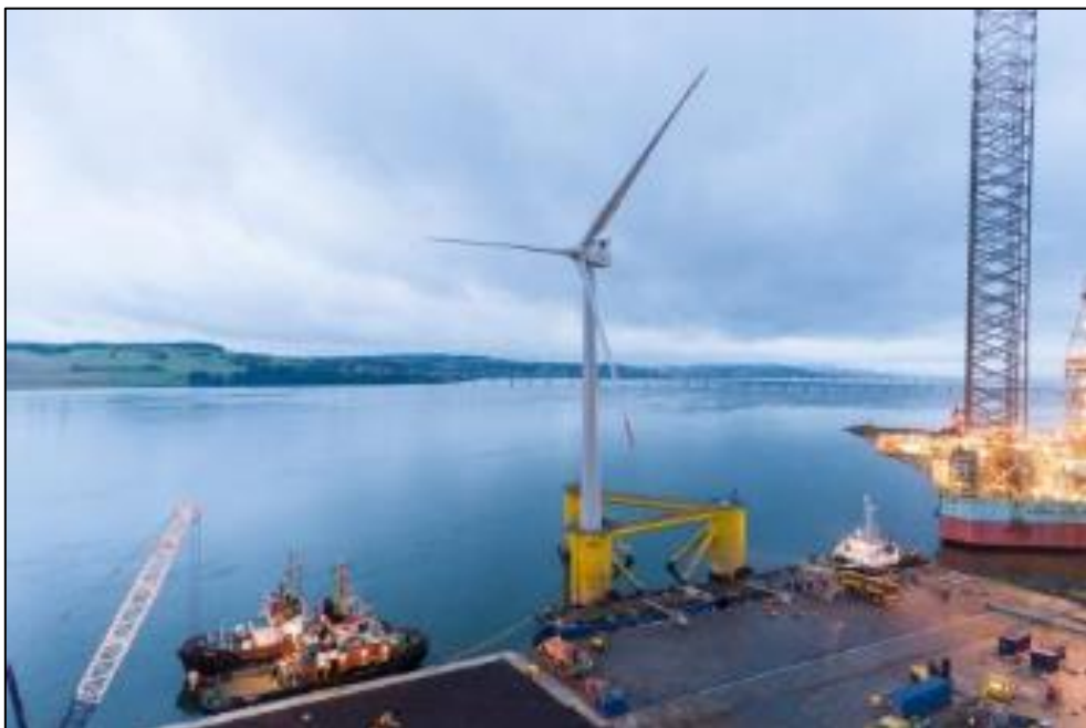
Figura 2-24 – Assemblaggio piattaforma galleggiante (Fonte kinkardine -Cobra)
