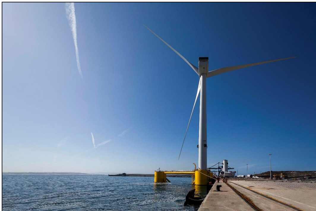
Figura 2-26 – Fasi di assemblaggio della piattaforma galleggiante (Fonte Windfloat Atlantic Project)
