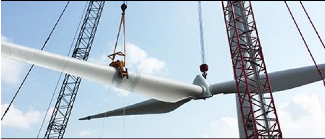
Figura 2-27 – Sollevamento del rotore (Fonte: Elronic Wind solution)
