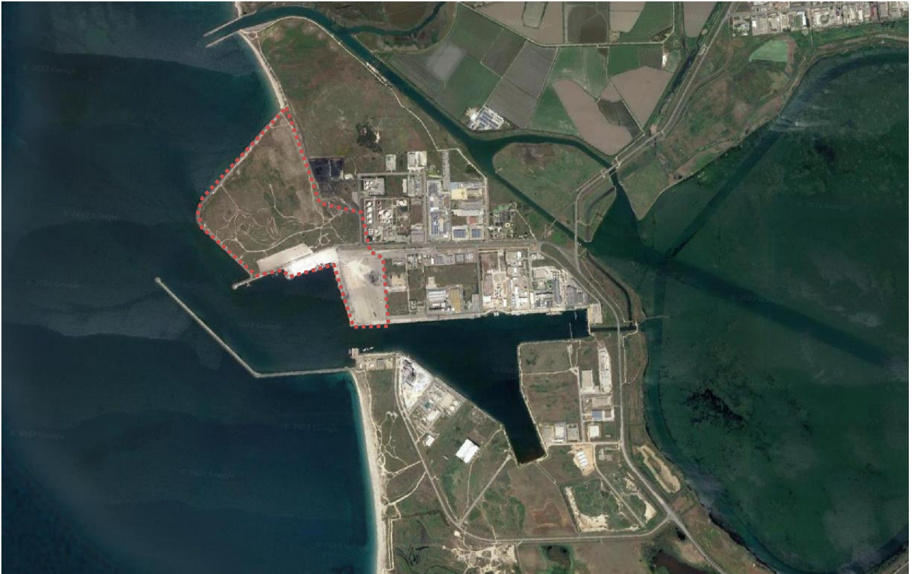
Figura 2.23 – Area portuale di Oristano, possibile sito di assemblaggio
