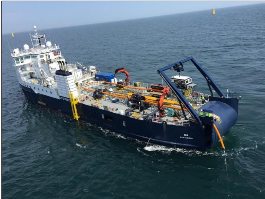
Figura 2-29 – Illustrazione dell'installazione del cavo (Fonte: Offshore Gode-wind)
