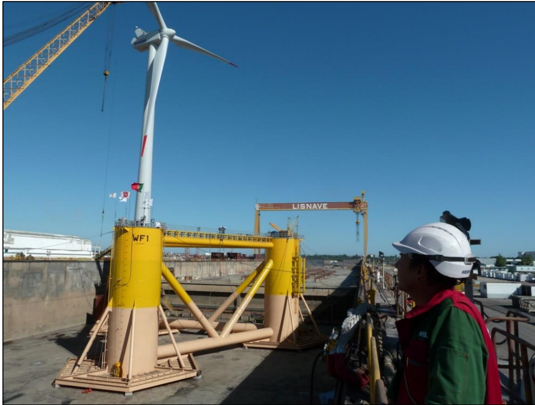
Figura 2-25 – Fasi di assemblaggio della piattaforma galleggiante (Fonte Windfloat Atlantic Project)
