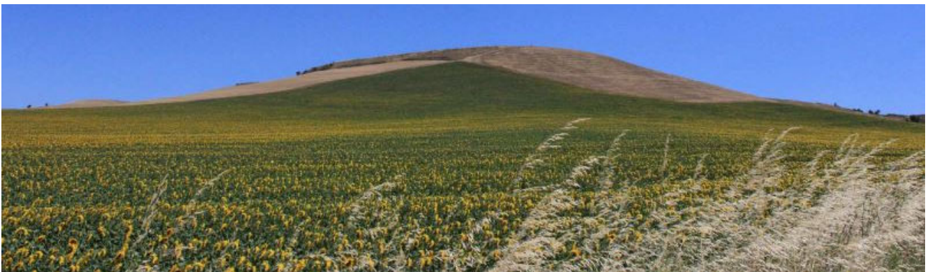
Area SUD dell'impianto fotovoltaico
