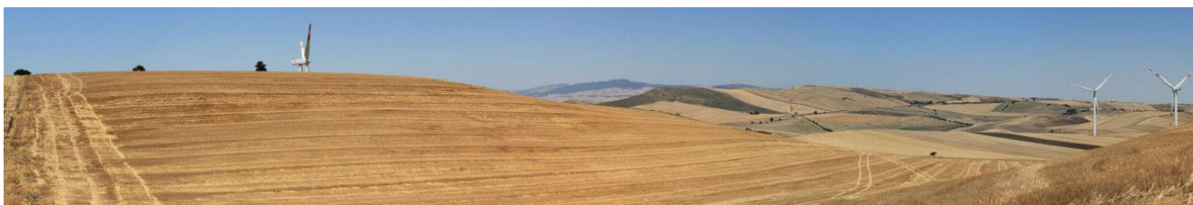
Area CENTRALE dell'impianto fotovoltaico
