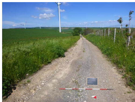
Fig. 58. CVD di collegamento tra i campi FV 1 e 3, visto da SE.
