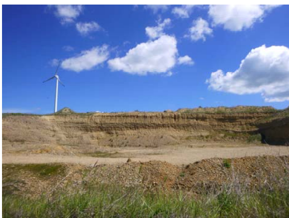
Fig. 59. CVD di collegamento tra i campi FV 1 e 3, particolare della cava, visto da O.
