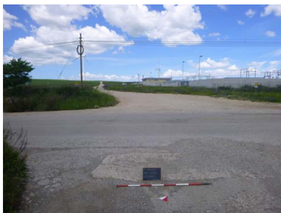
Fig. 62. CVD di collegamento tra i campi FV 1, 2e 3 e la S.E. Terna, particolare della stazione elettrica, visto da SE.
