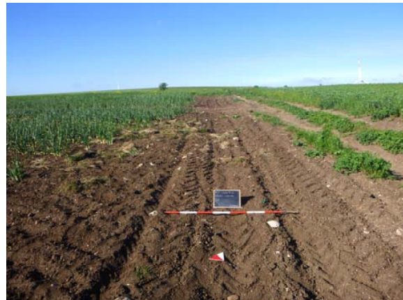
Fig. 56. CVD di collegamento tra i campi FV 1 e 2, visto da NE.
