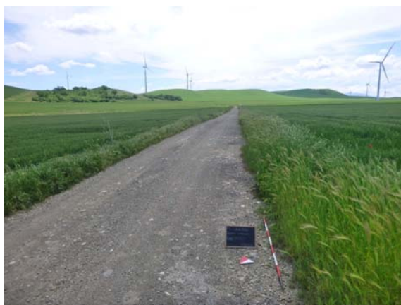
Fig. 60. CVD di collegamento tra i campi FV 1, 2e 3 e la S.E. Terna, visto da NO.
