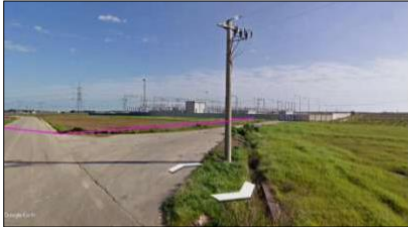
Fig.22: Punto di attacco alle SSE Brindisi Sud
