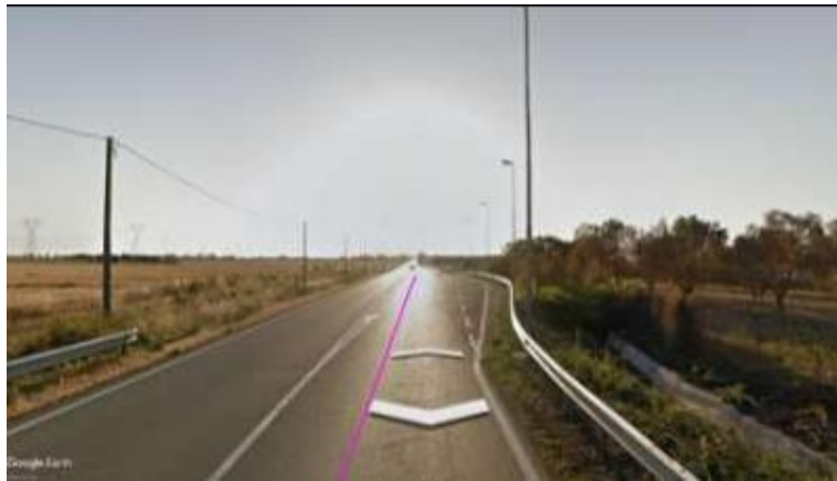
Fig.20: Punto di inizio dell'elettrodotto - SP 81
