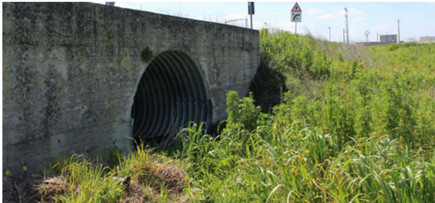
Fig. 13 – Particolare della sezione del canale in corrispondenza del ponte stradale.
