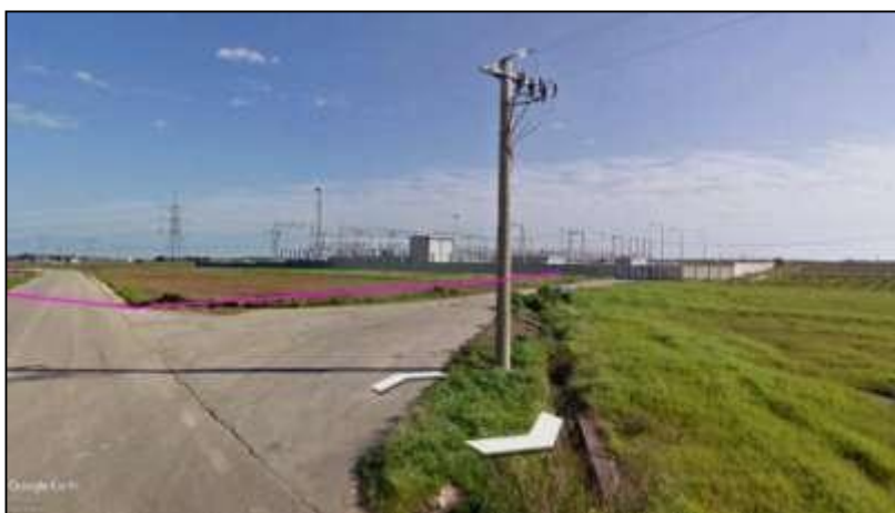
punto di attacco alla SSE – Brindisi sud – SP 81
