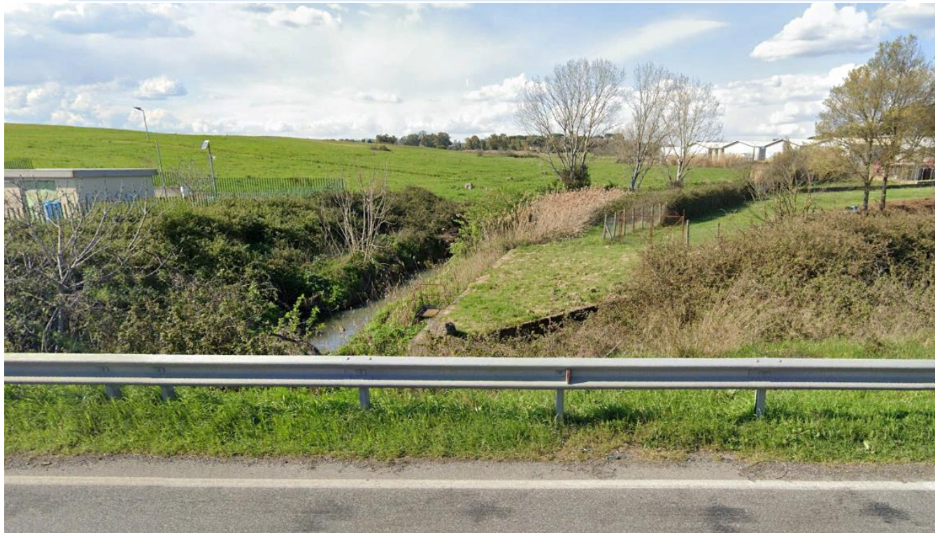
Figura 5-38 - Vista del fosso della Casaccia, dalla SP493 a sud del Centro Ricerche ENEA Casaccia
