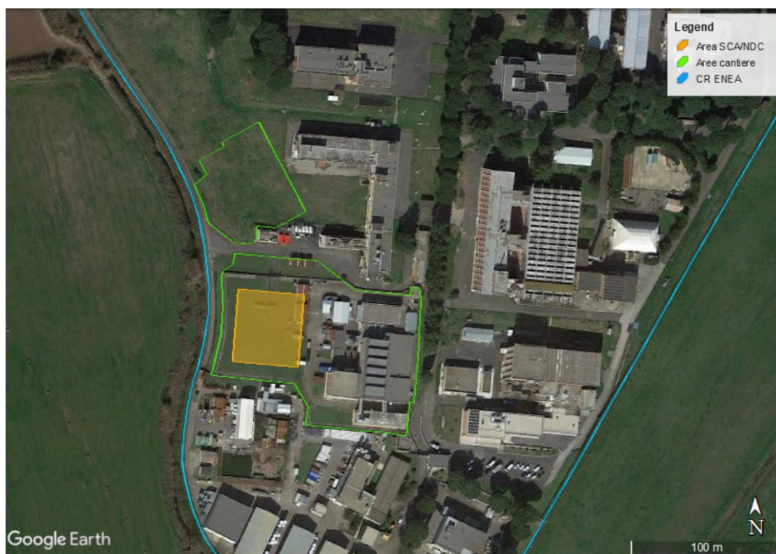
Figura 9-2 - In arancione l'area di cantiere interessata dalla fase di picco delle emissioni in atmosfera
