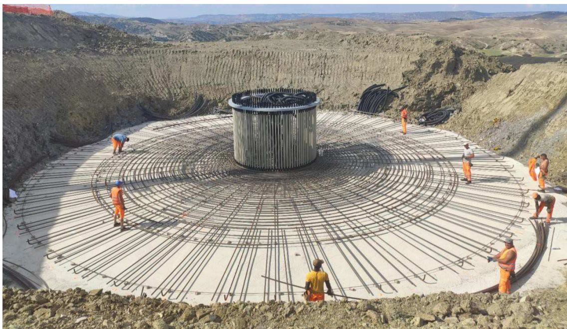
Figura 8: Posa anchor cages tipo
