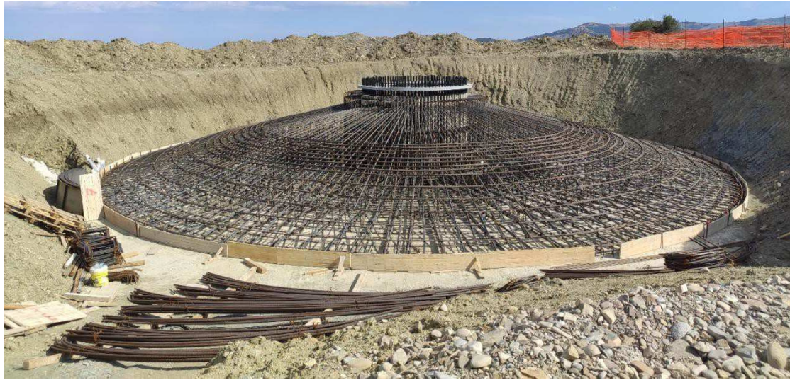
Figura 9: armatura plinto tipo
