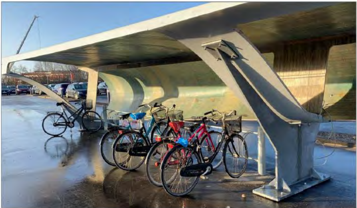
Figura 4-29: Esempio di riutilizzo: Installazione Deposito biciclette ad Aalborg, Danimarca
