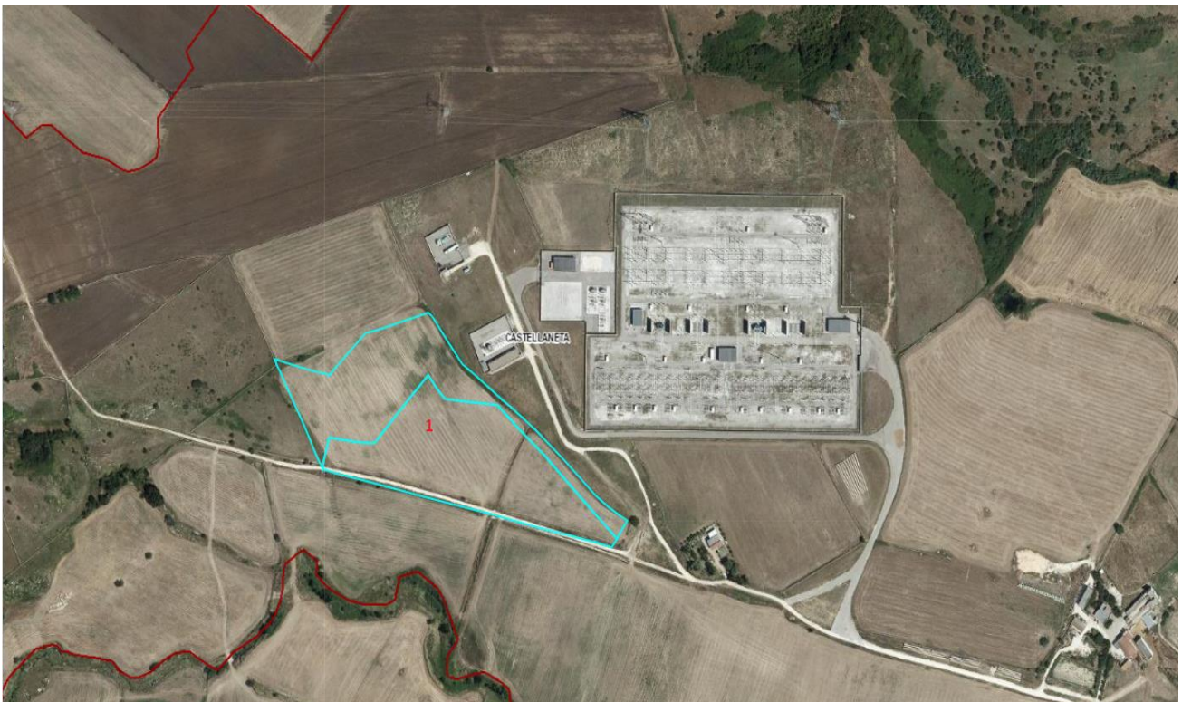
Figura 4-11: Punti cattura foto stazione elettrica
