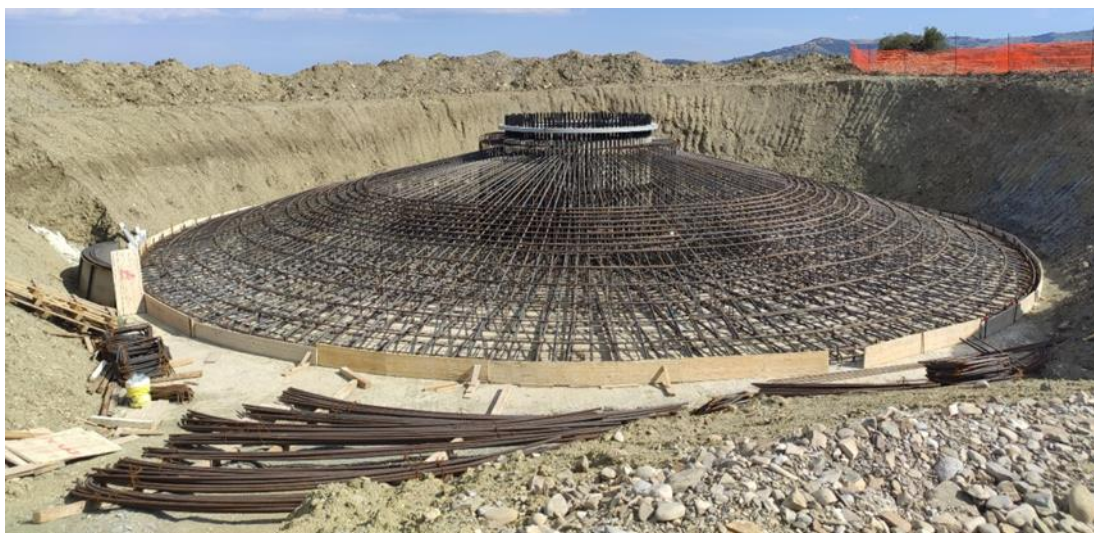
Figura 5-4: immagine tipo armature plinto
