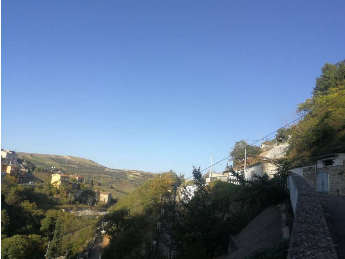
Foto 15a – Punto di Presa n° 15 Stato di Fatto
