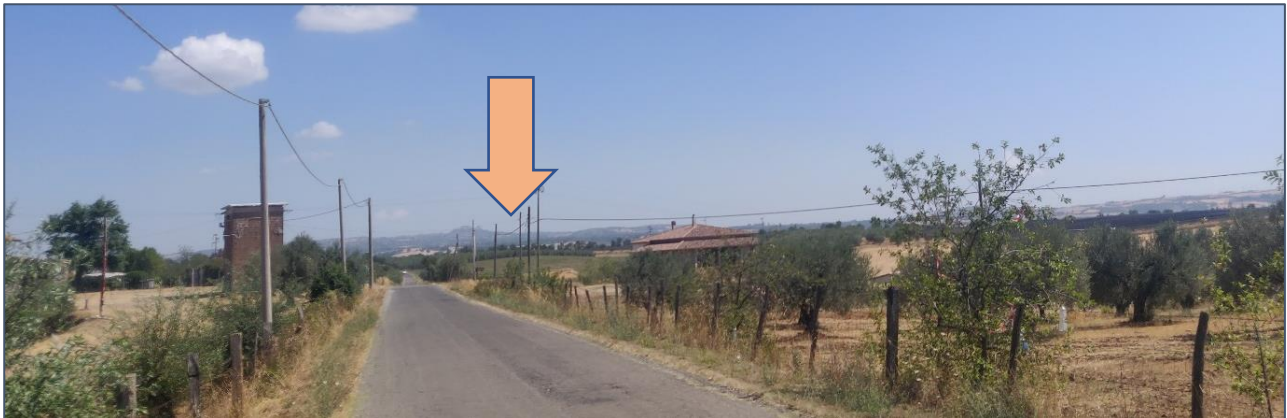
Figura 6 - PDV 2, Stato di fatto
