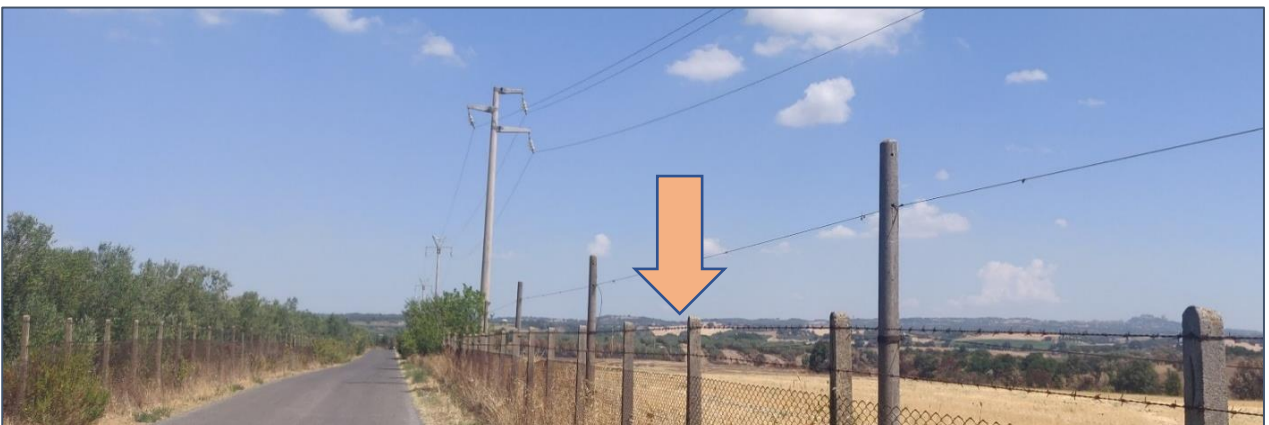
PDV 3, Stato di fatto
