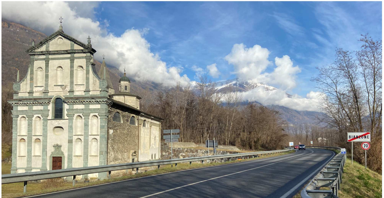
Figura 79: Santuario della Madonna del Piano; sullo sfondo il tratto stradale oggetto di intervento (tratta 4)
