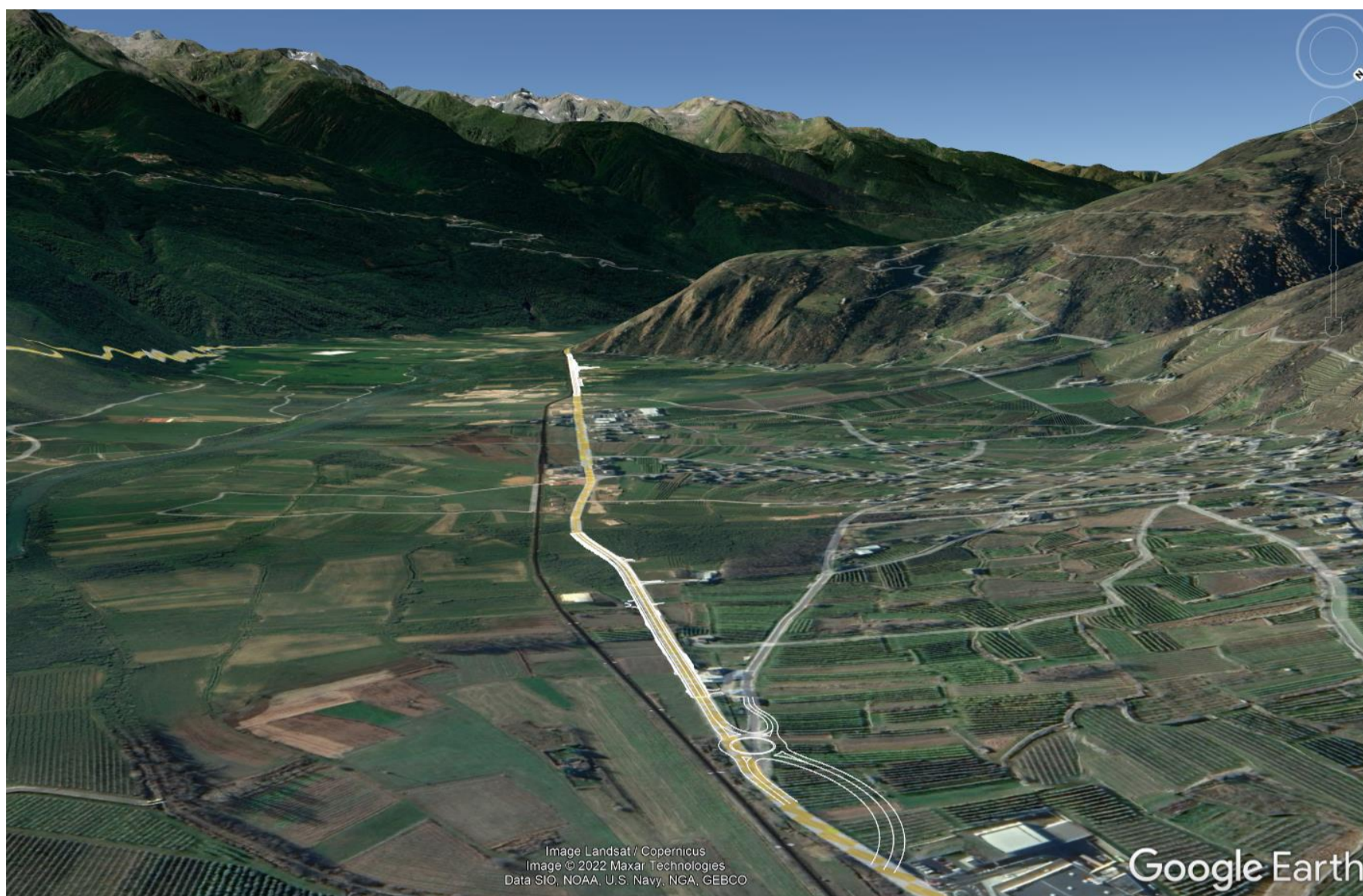
Figura 23: Vista a volo d’uccello con sovrapposizione del progetto da nord (Fonte: Google Earth) – Tratta 4
