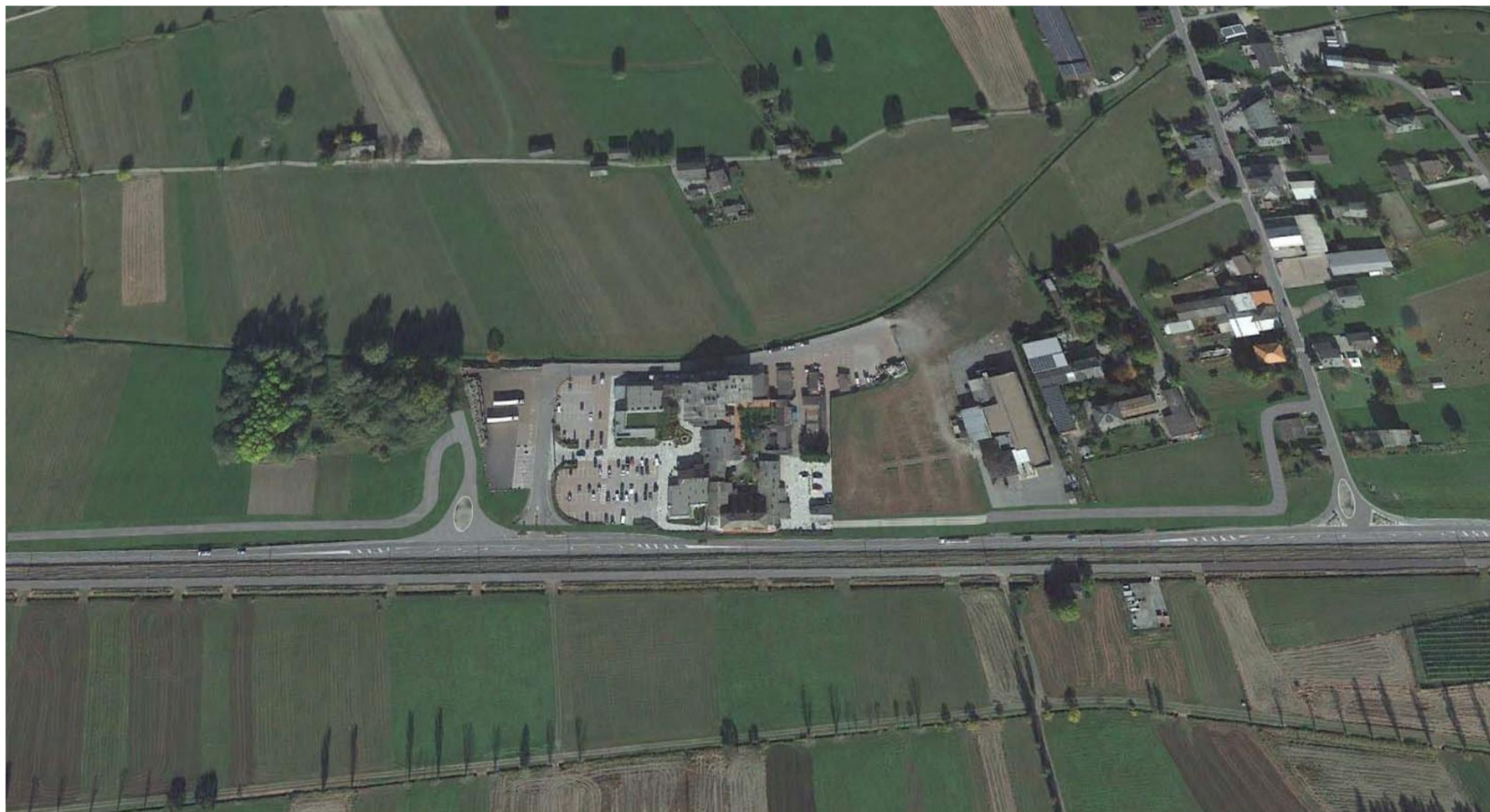
Figura 7: Vista a volo d'uccello – TRATTA 1, Intervento Intersezione T1-I2 e viabilità VS03 – FOTOSIMULAZIONE
