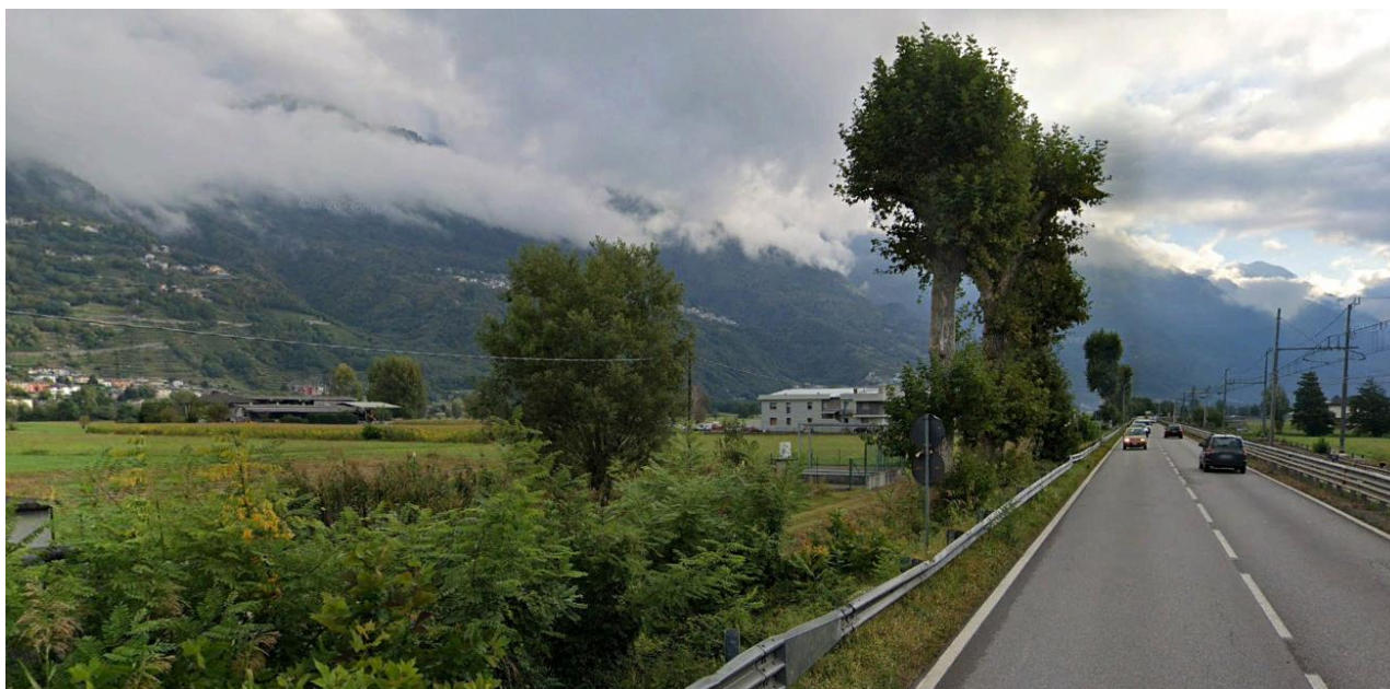
FOTO 1 – Tratta 1: vista della SS38 direzione Tirano. In questo tratto è previsto l'adeguamento con sezione Tipo A per inserimento della banchina laterale. Sarà necessario il taglio del filare di platano esistente a bordo strada.
