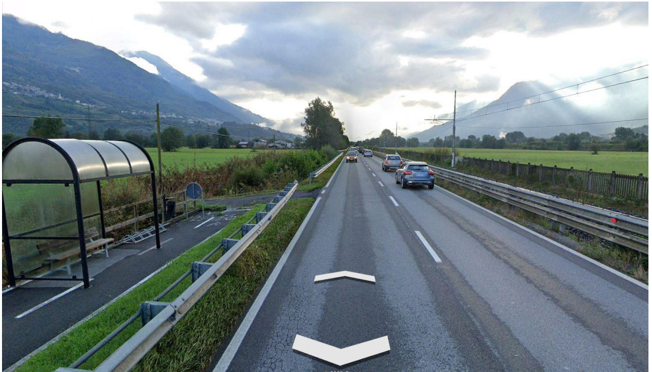
FOTO 1: Tratta 2: vista della SS38 direzione Tirano. In questo tratto è previsto l'adeguamento con sezione Tipo A per inserimento della banchina laterale. All'altezza degli alberi sarà realizzata la strada bianca locale (VS01).
