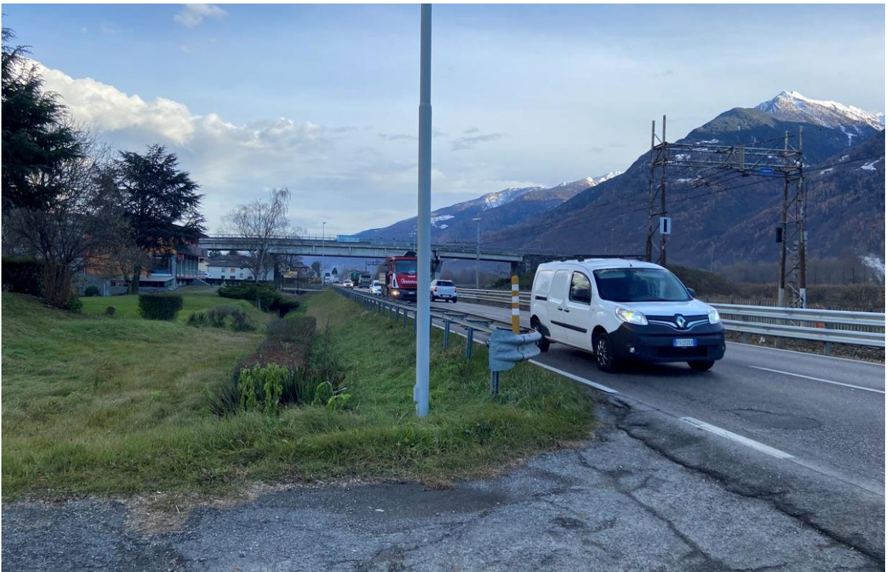
FOTO 12: Tratta 2: Vista della SS38 direzione Tirano. In questo tratto è previsto l'adeguamento con sezione Tipo F per inserimento della banchina laterale e la realizzazione della strada locale VS05 e tombinamento canale esistente.
