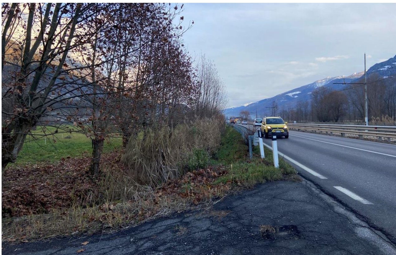
FOTO 4: Tratta 2: Vista della SS38, direzione Tirano. In questo tratto è previsto l'adeguamento con sezione Tipo A per inserimento della banchina laterale; più avanti sarà realizzata la VS02.
