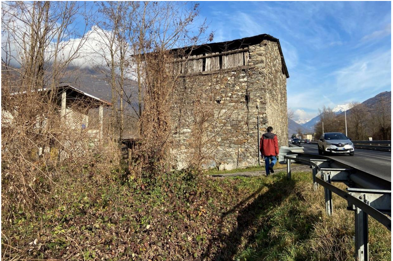
FOTO 6: tratta 3 - Vista dell'edificio interferente da espropriare, direzione Tirano. In questo tratto è previsto l'adeguamento con sezione Tipo C per inserimento della banchina laterale e viabilità secondaria categoria F2.
