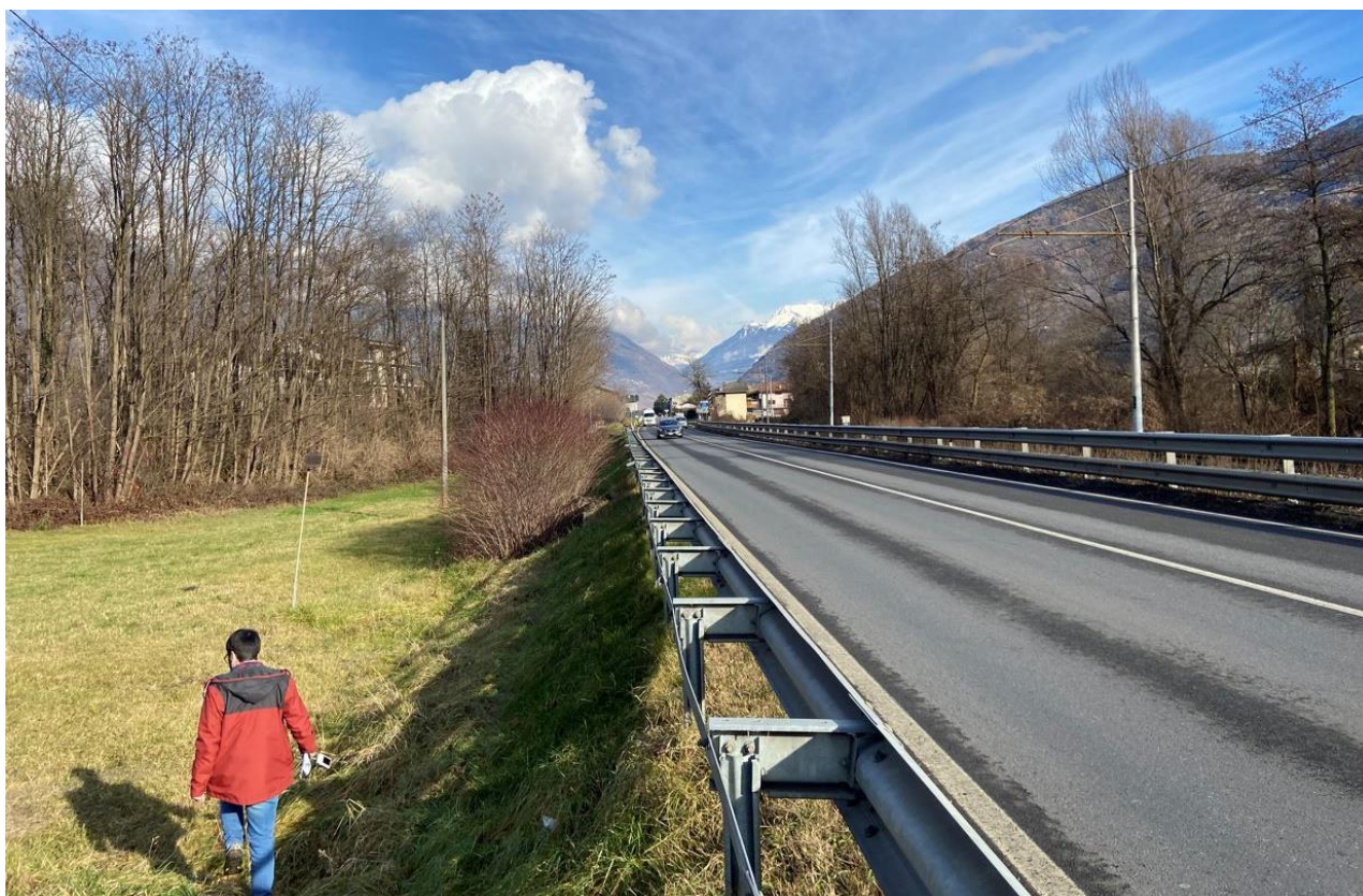
FOTO 8: tratta 3 - Vista della SS38 direzione Tirano. In questo tratto è previsto l'adeguamento con sezione Tipo A per inserimento della banchina laterale.
