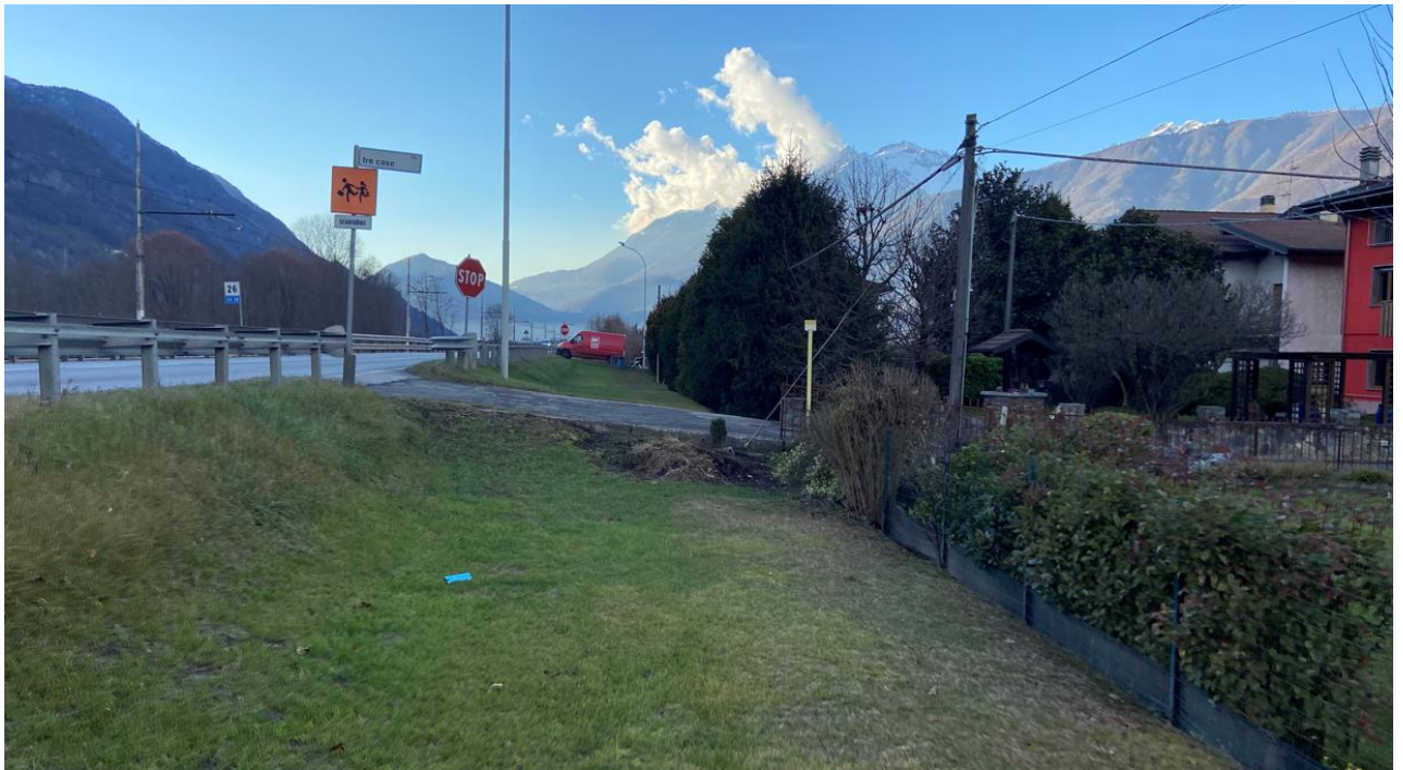
FOTO 7: Tratta 2: Vista dell'accesso dalla SS38 alla nuova viabilità locale, direzione Colico. In questo tratto è previsto l'adeguamento con sezione Tipo A per inserimento della banchina laterale e la chiusura degli accessi diretti.
