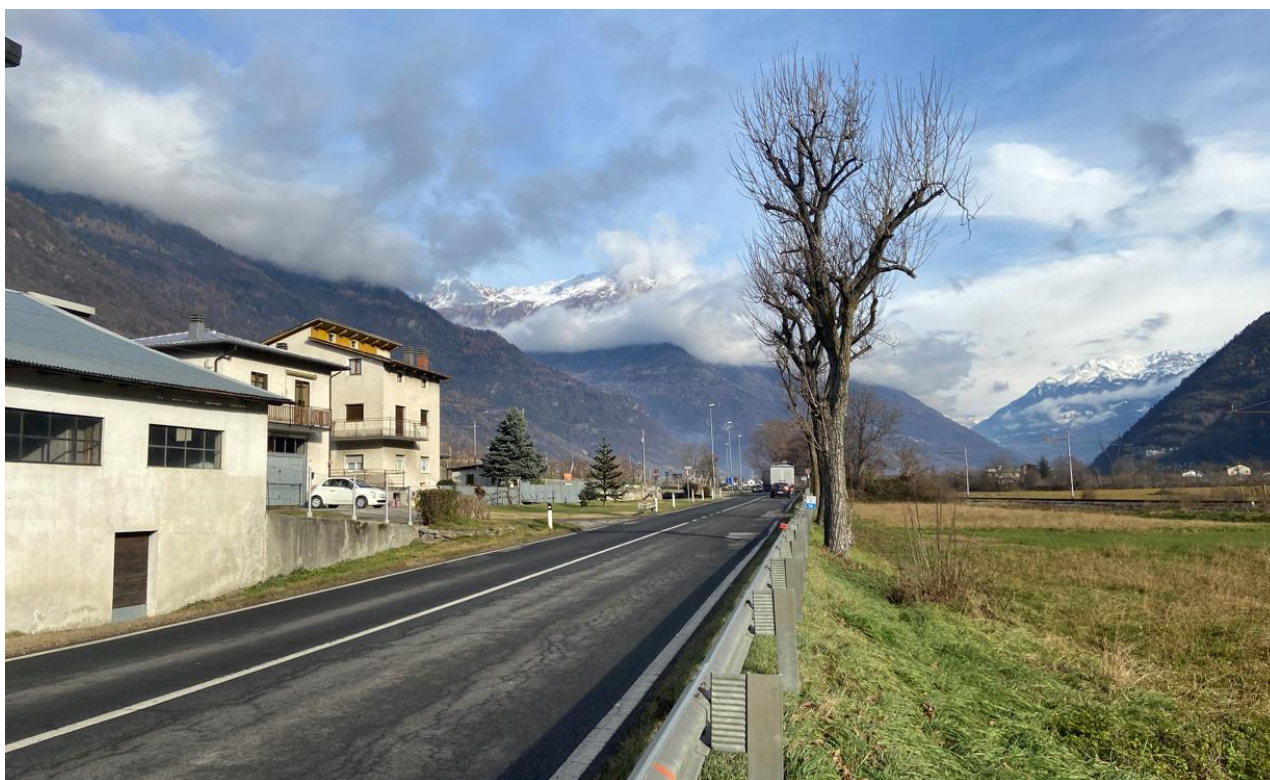
FOTO 8: tratta 4: Vista della SS38 direzione Tirano.
