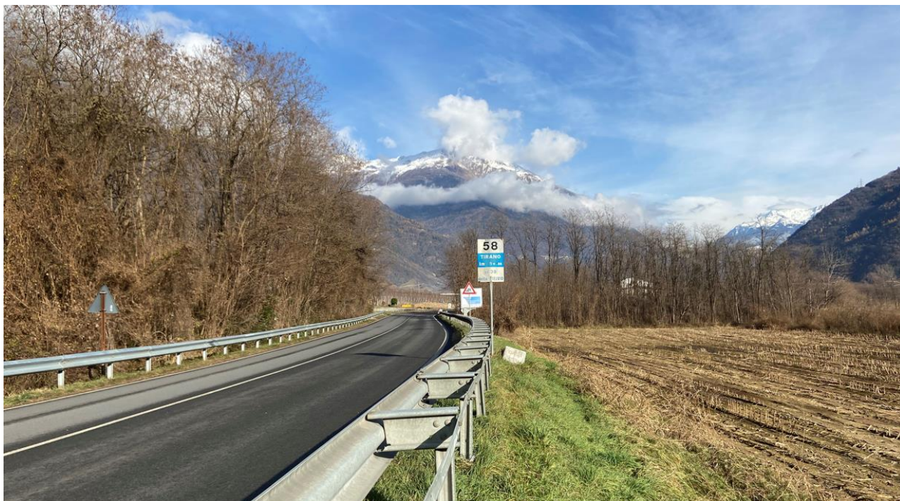
FOTO 3: tratta 4: Vista della SS38 direzione Tirano
