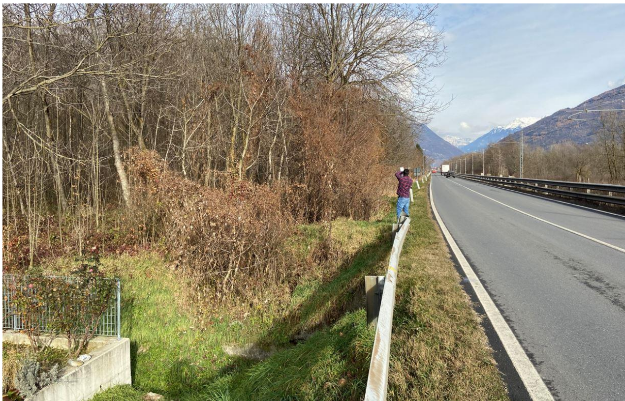
FOTO 2: tratta 3 - Vista della SS38 direzione Tirano. In questo tratto è previsto l'adeguamento con sezione Tipo A per inserimento della banchina laterale.
