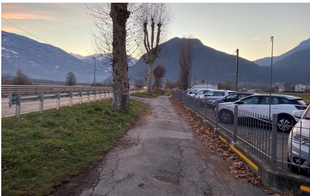
FOTO 2 – Tratta 1: Vista della SS38 direzione Colico. In questo tratto è previsto l'adeguamento con sezione Tipo A per inserimento della banchina laterale. Sarà necessario il taglio del filare di platano esistente a bordo strada
