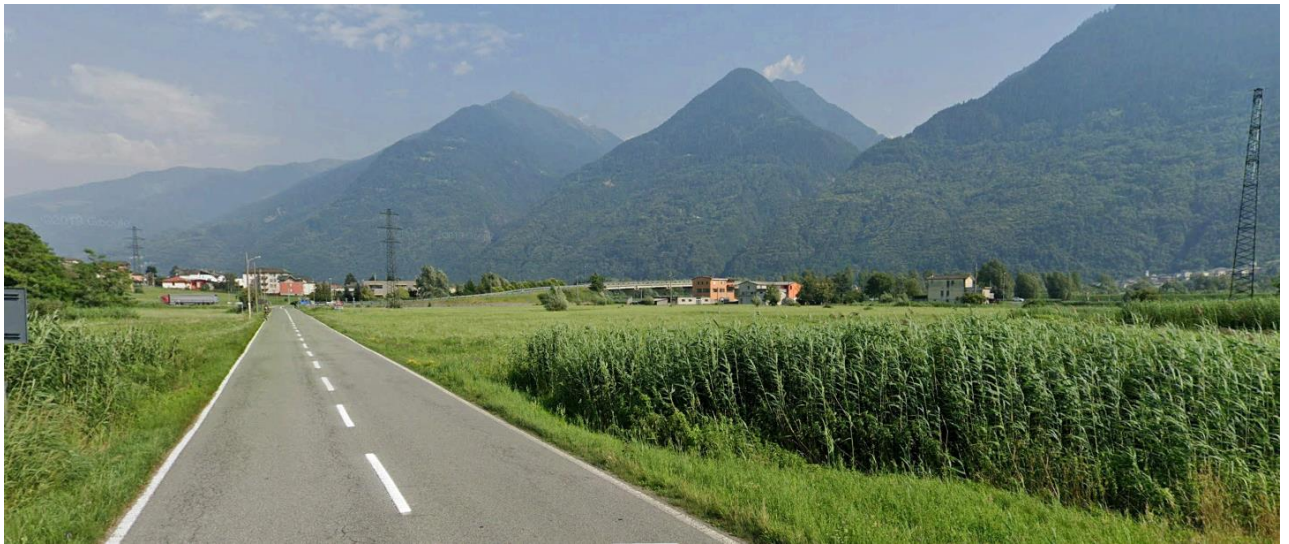
FOTO 17: Vista dalla SP12 verso l'area in cui sarà realizzata la nuova rotatoria De=40 m del nuovo raccordo tra la SS38 e la SP12.
