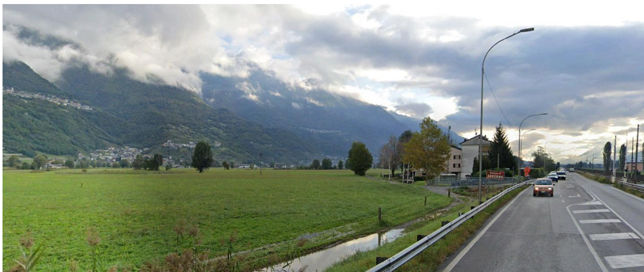
FOTO 5 – Tratta 1: vista della SS38 direzione Tirano. In questo tratto è prevista la corsia di decelerazione della nuova intersezione e sulla sinistra la viabilità RFI in progetto da adeguare.
