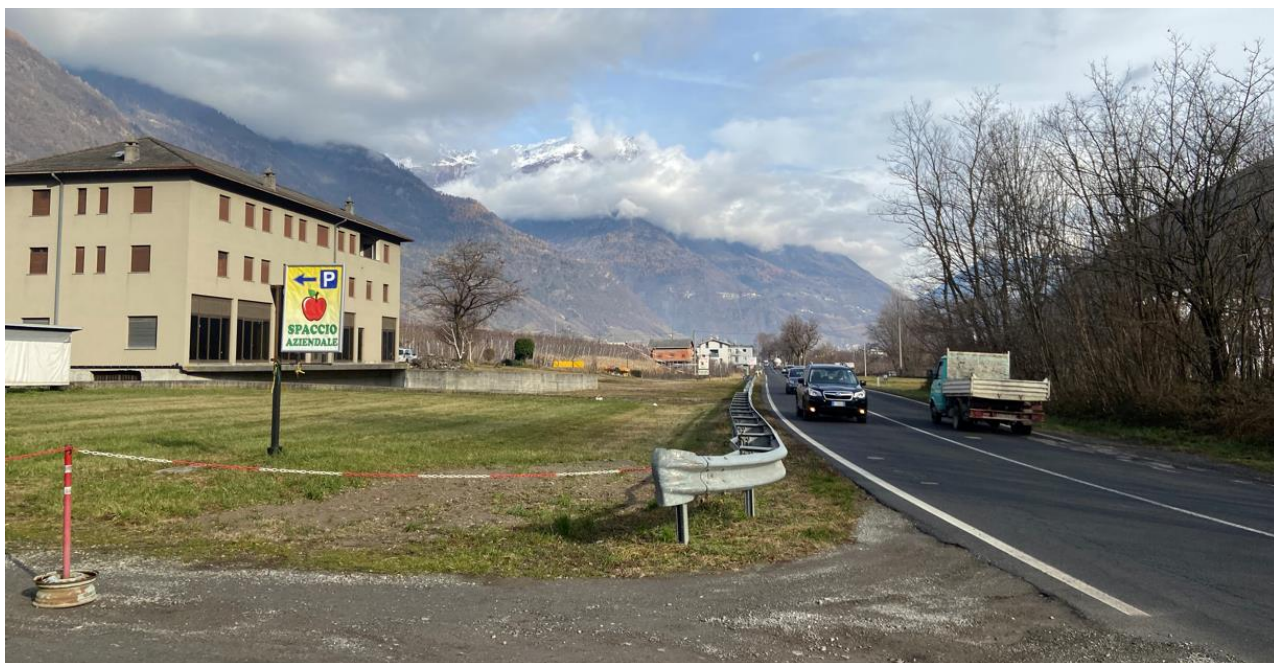
FOTO 4: tratta 4: Vista della SS38 direzione Tirano.
