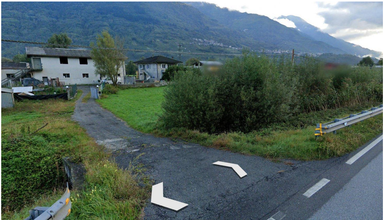
FOTO 2: Tratta 2: vista della SS38 verso l'attuale accesso diretto che sarà chiuso e garantito dalla VS01 in progetto.
