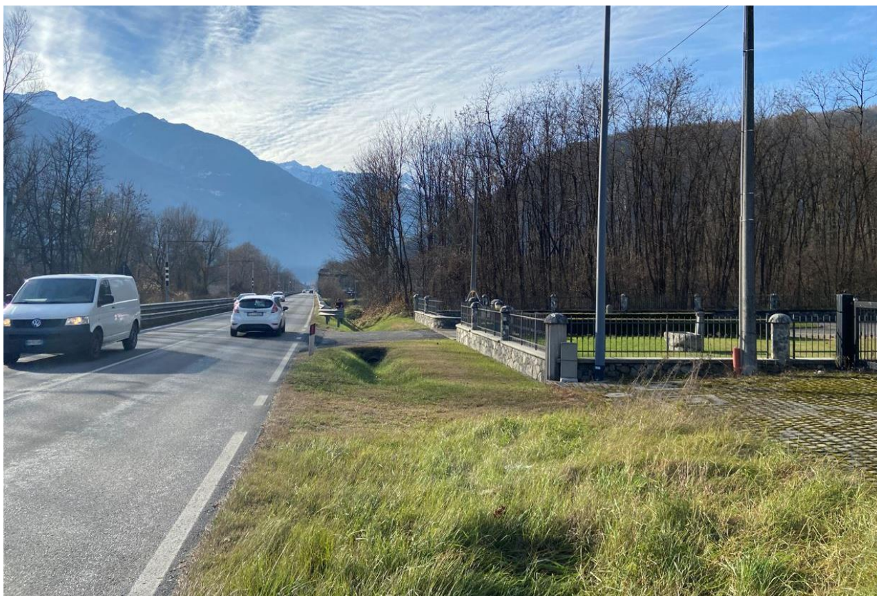
FOTO 9: tratta 3 - Vista della SS38 direzione Colico. In questo tratto è previsto l'adeguamento con sezione Tipo A per inserimento della banchina laterale.
