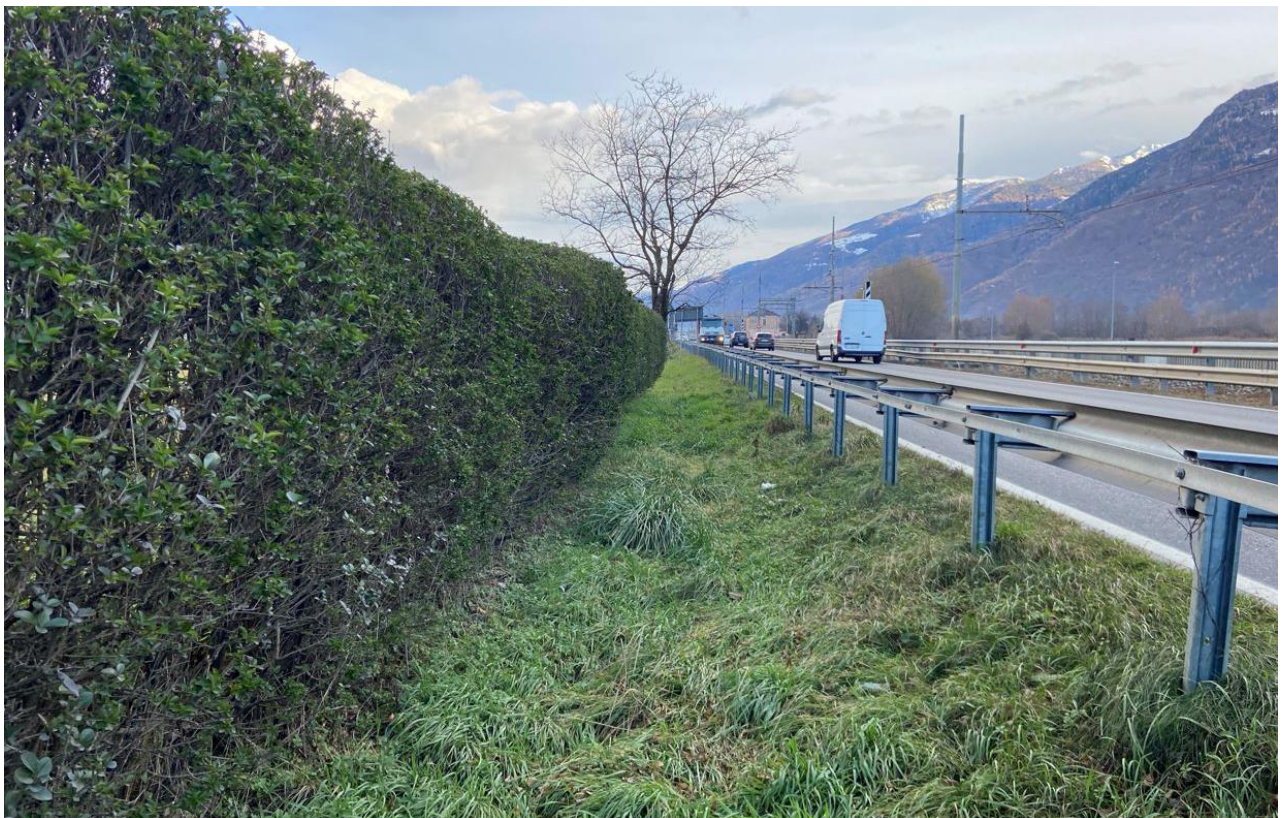
FOTO 14: Vista della SS38 direzione Tirano. In questo tratto è previsto l'adeguamento con sezione Tipo A per inserimento della banchina laterale.
