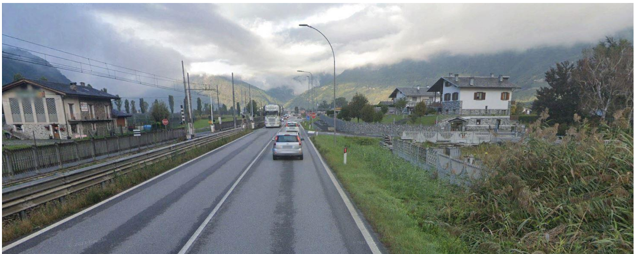
FOTO 14: Tratta 1: Vista della SS38 direzione Colico: sulla destra un'intersezione esistente da chiudere (l'accesso avverrà dall'intersezione TI-I3 più avanti).
