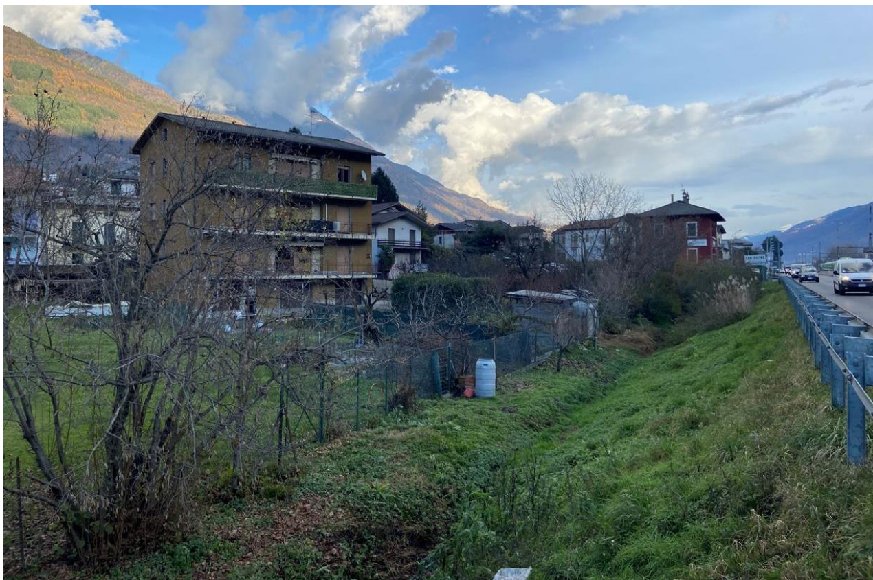
FOTO 15: Vista della SS38 direzione Tirano. In questo tratto è previsto l'adeguamento con sezione Tipo A per inserimento della banchina laterale.
