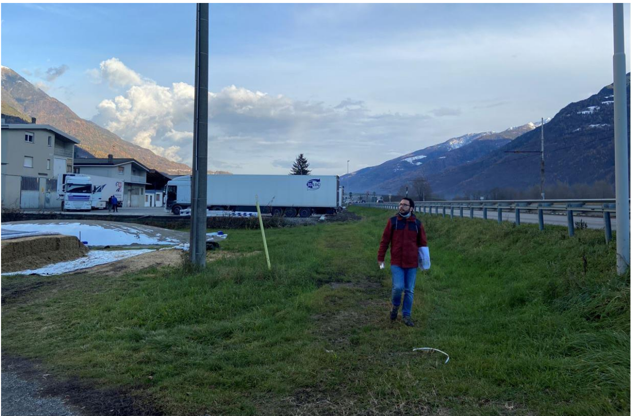
FOTO 10: tratta 2: Vista della SS38 direzione Tirano. In questo tratto è previsto l'adeguamento con sezione Tipo D2 per inserimento della banchina laterale e la realizzazione della strada locale VS03.
