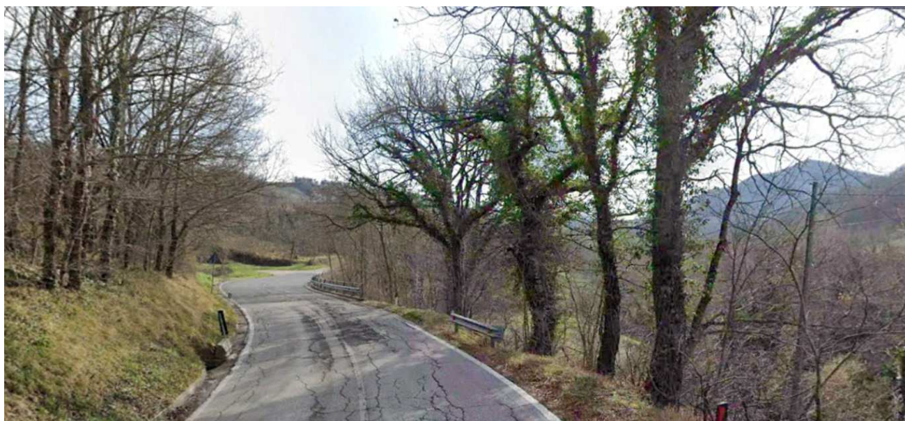
Foto 20 vista sud est
