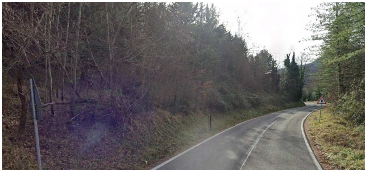
Foto 25 vista sud est
