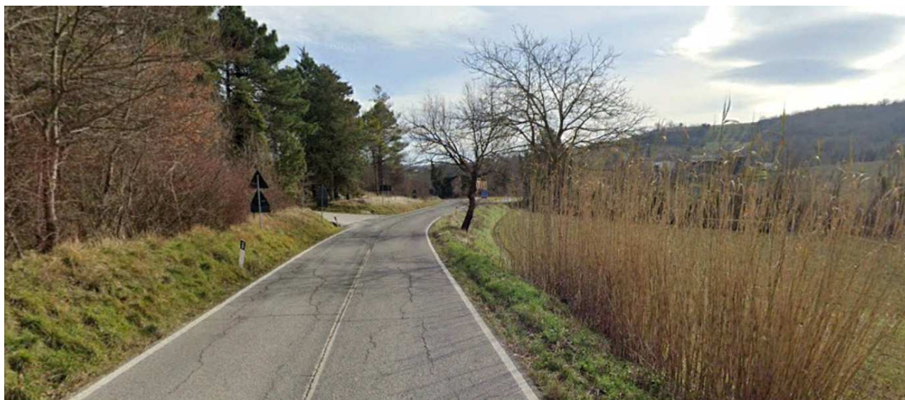
Foto 27 vista sud est
