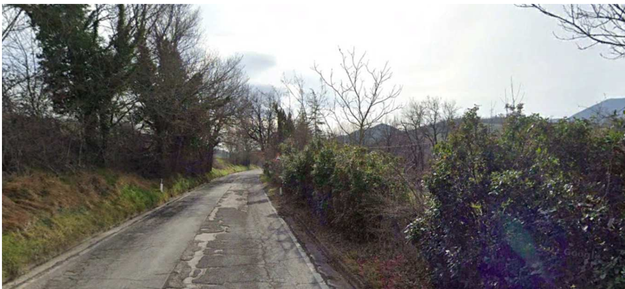
Foto 17 vista sud est
