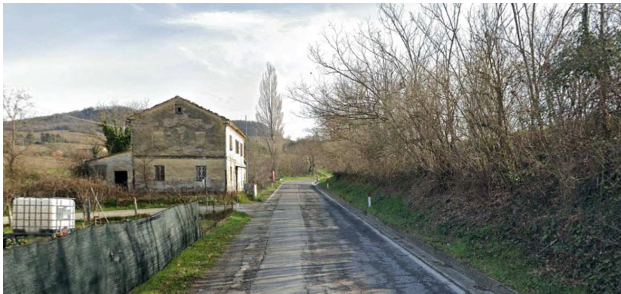
Foto 11 vista sud est
