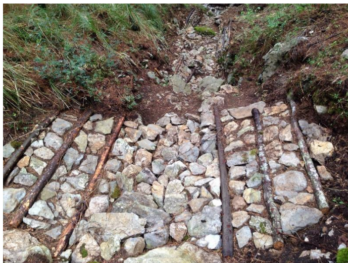
Figura 39: esempio di intervento di ingegneria naturalistica di sistemazione impluvi con legname e pietrame
