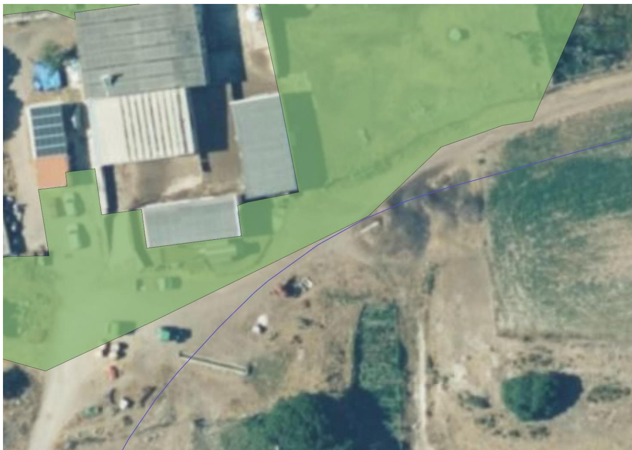
Figura 4: Particolare del cavidotto
