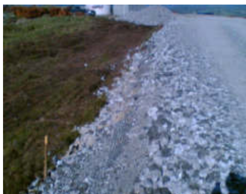
Figura 13: Superficie stradale in misto stabilizzato e drenaggio
