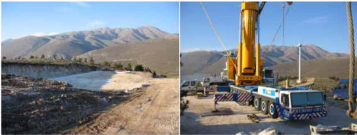
Figura 14: piazzole e gru per il montaggio pale
