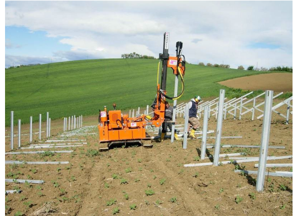
Figura 5 - Posa strutture metalliche di fondazione
