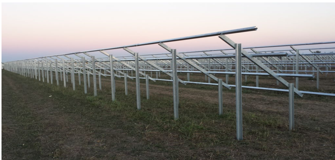
Figura 6: - Stato cantiere al termine della fase lavorativa
