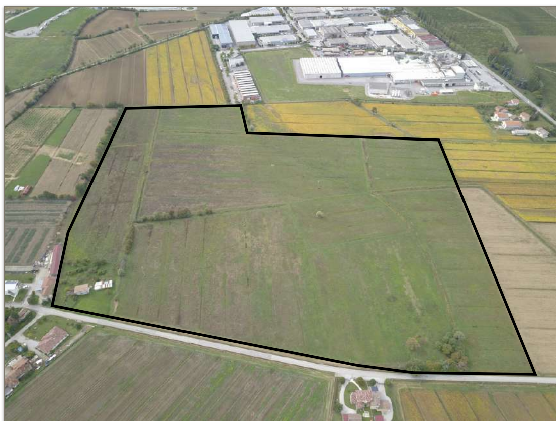
Figura 3: Vista da NE verso SW dell'area d'intervento - volo drone settembre 2022
