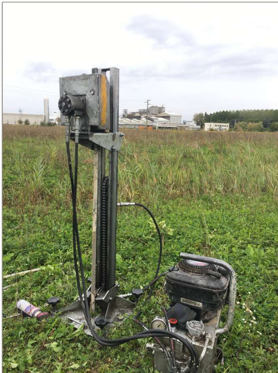
Esecuzione Prova DPM_2 in data 28.09.2022
