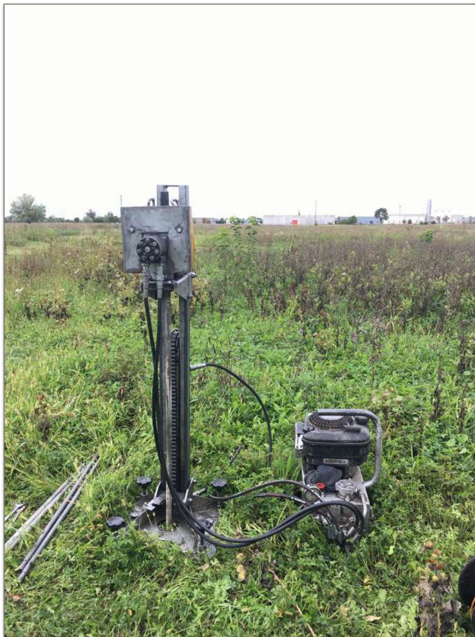
Esecuzione Prova DPM_1 in data 28.09.2022
