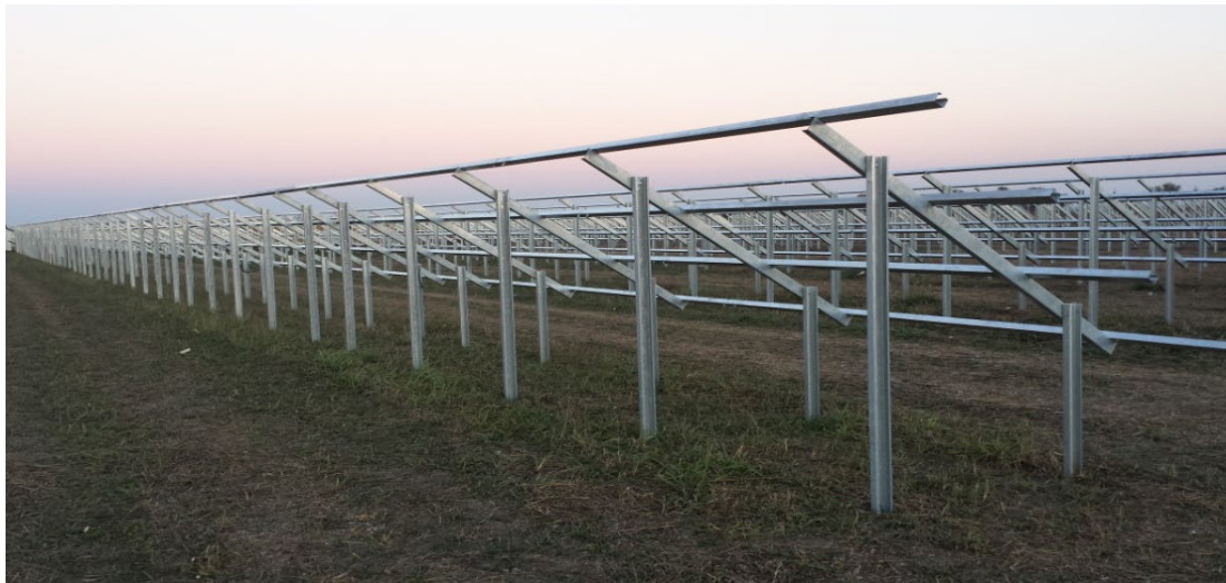
Figura 1-4 – Stato cantiere al termine della fase lavorativa
