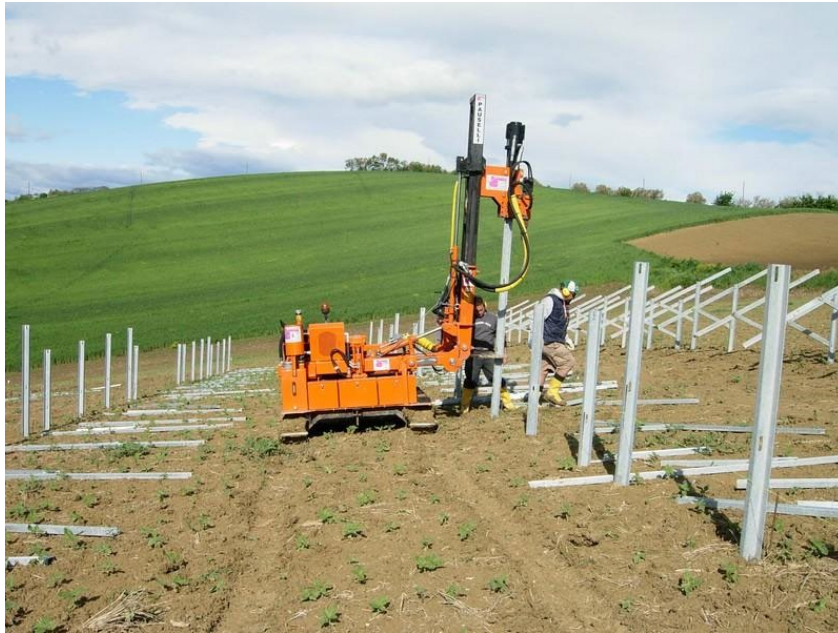
Figura 1-4 – Posa strutture metalliche di fondazione
